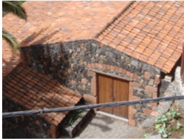
Figura 2. Exterior del Centro de la Naturaleza de Masca.
