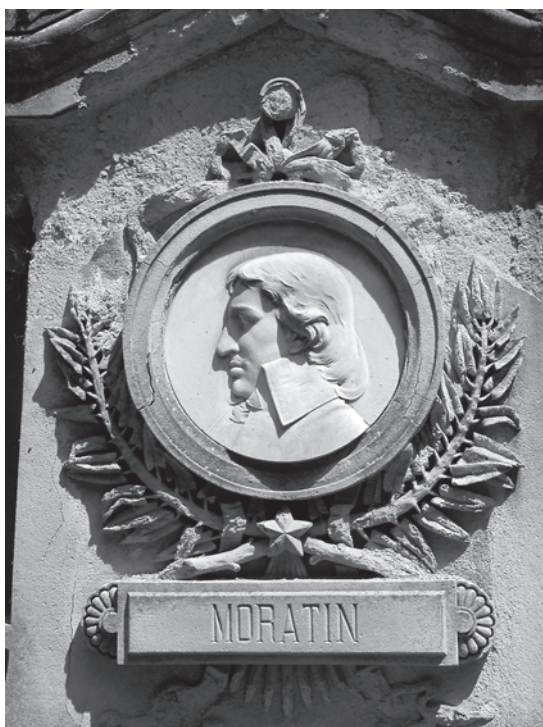
Foto 15. Detalle del medallón de Moratín, donde se aprecia la erosión de la piedra artificial. Cementerio de San Isidro.
