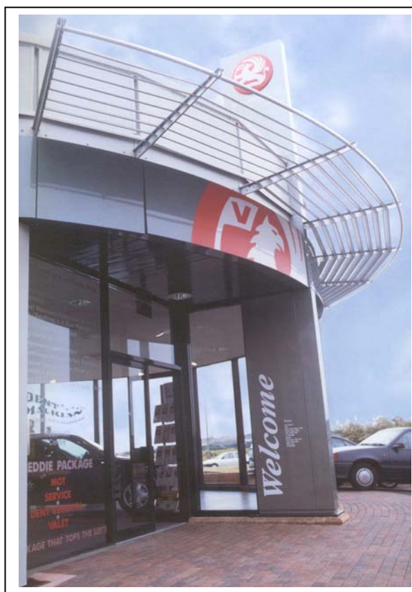
Fig. A2 – Ejemplos de edificaciones que tienen instalados los sombreadores tipo lamas (fotografías de la empresa MAPLE SUNSCREENING, UK)
