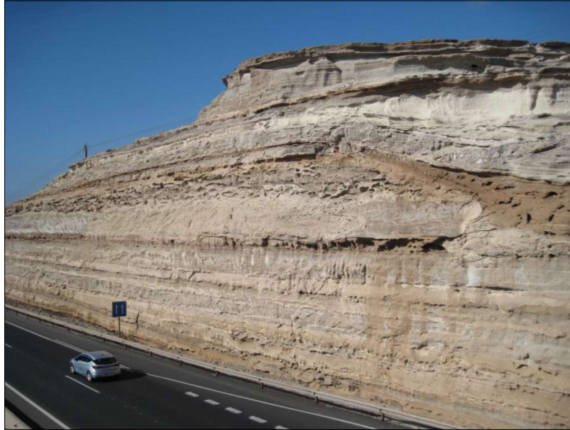
Figura 6.5. Imagen del talud 5. (Foto: Ana Miranda)
