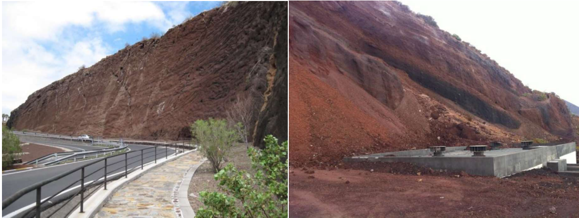
Figura 4.9. Ejemplos de macizos tipo B con distinto grado de soldamiento, a la izquierda con cierto grado de cohesión, y a la derecha piroclastos sueltos (Fotos: Ana Miranda izq. y Luis Hernández dcha.)
