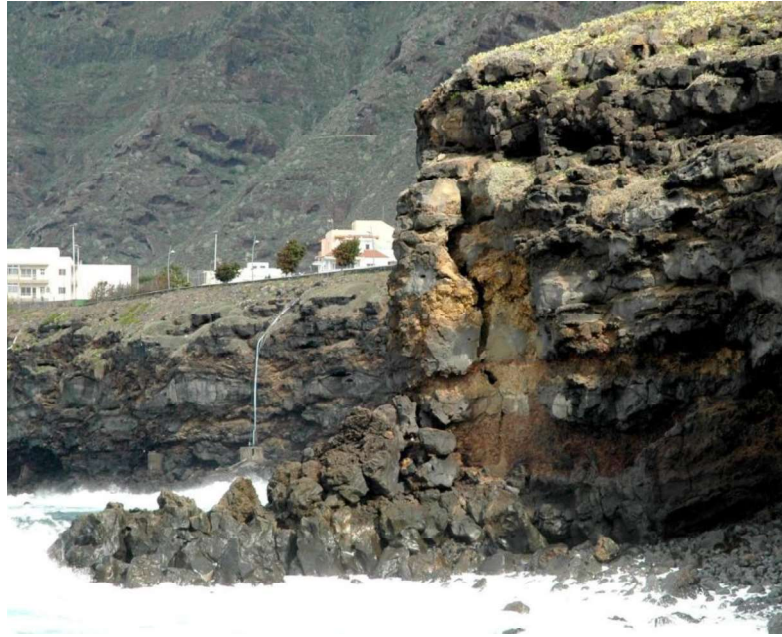
Figura 4.13. Acantilado afectado por la erosión marina. (Foto: Ana Miranda).
