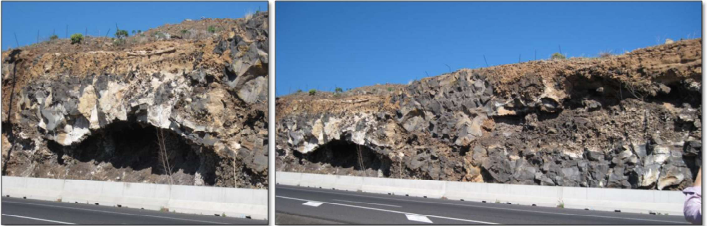
Figura 6.6. Imagen del talud 6. (Fotos: Ana Miranda)
