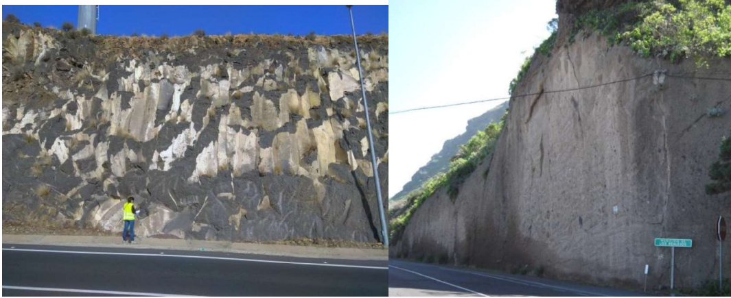
Figura 4.4. Ejemplos de macizos tipo A. A la izquierda macizo basáltico y a la derecha talud en piroclastos sálicos. (Fotos: Ana Miranda).
