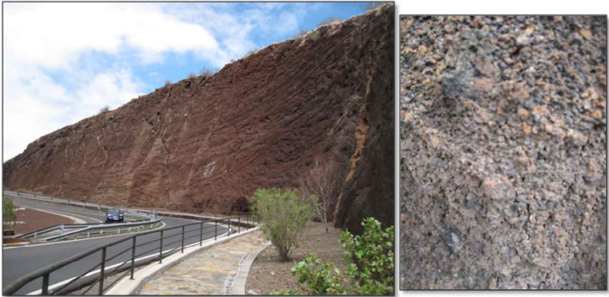
Figura 6.3. Imagen del talud 3 y detalle de los piroclastos que lo forman. (Fotos: Ana Miranda)
