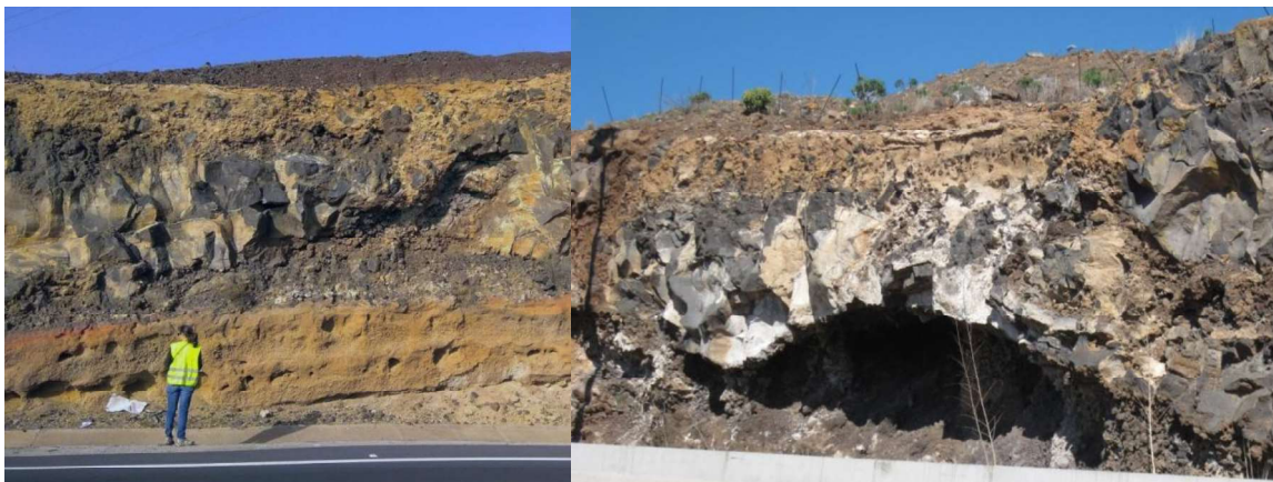
Figura 4.11. Ejemplos de macizos tipo C. A la izquierda se observa la alternancia de materiales y a la derecha formación de cornisas en el talud. (Fotos: Ana Miranda).
