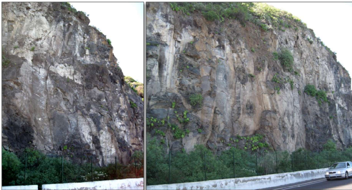
Figura 6.1. Imagen del talud 1. (Fotos: Ana Miranda)
