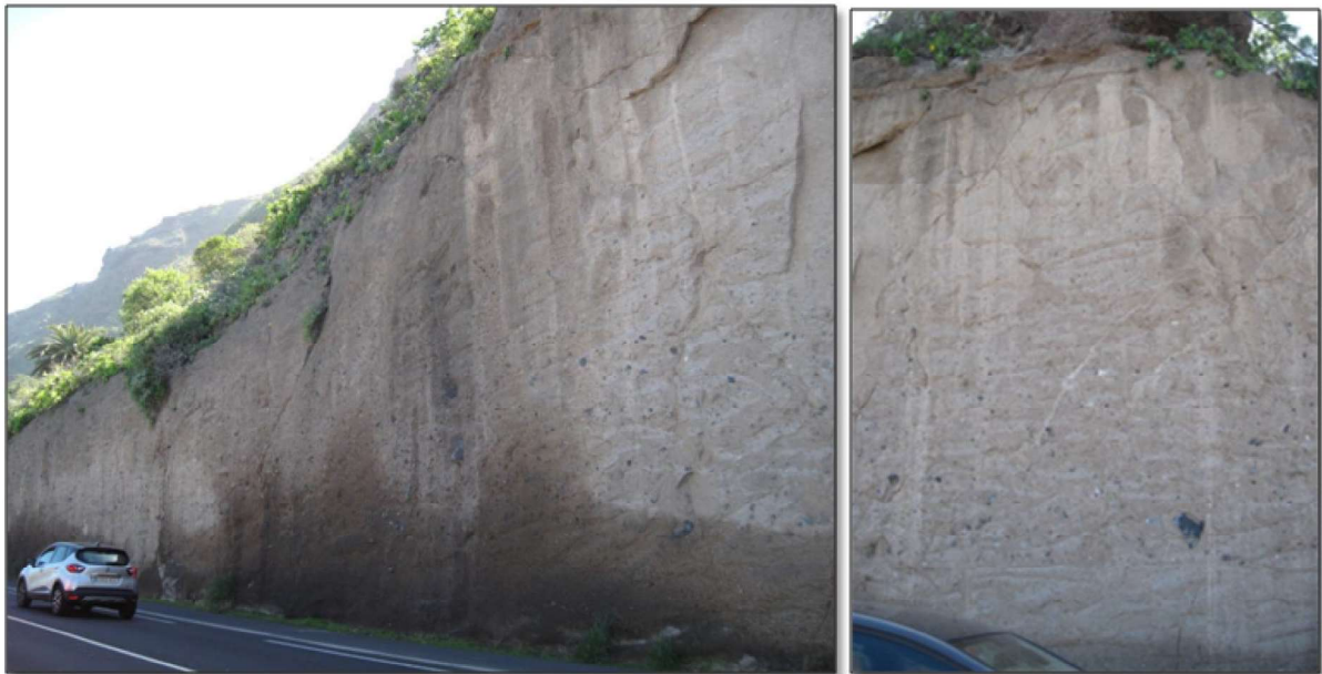
Figura 6.2. Imagen del talud 2. (Fotos: Ana Miranda)
