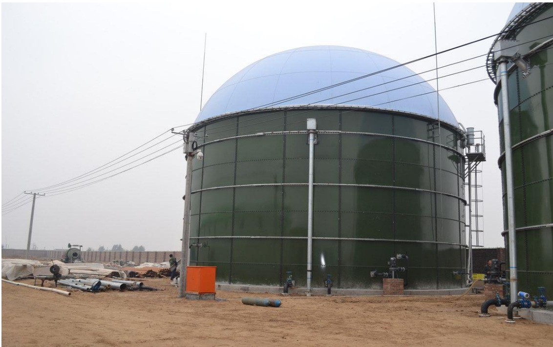
Figura 17. Tanque de vidrio fundido al acero con cubierta de doble membrana. Fuente: CEC Tanks.
