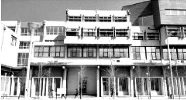
FIGURA 6.3 VISTA EN DETALLE DE LA FACHADA SUR
