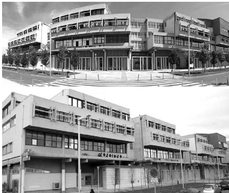
FIGURA 6.1 DOS VISTAS GENERALES DE LA FACHADA SUR DEL EDIFICIO
