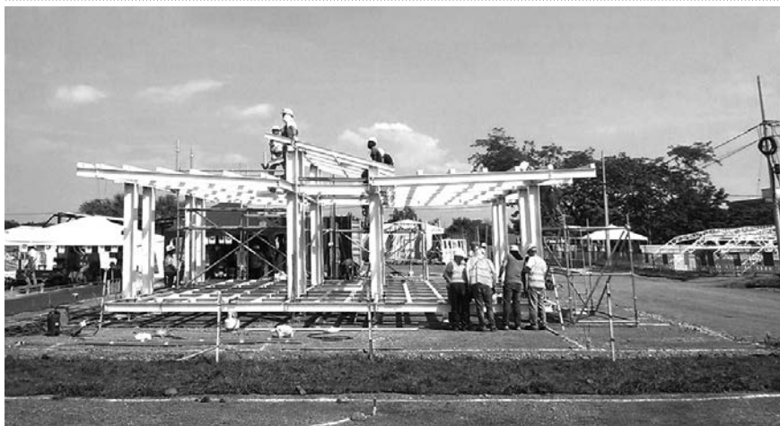
FIGURA 5.2 ENSAMBLAJE DEL PROTOTIPO CASA ALERO EN LA VILLA SOLAR
