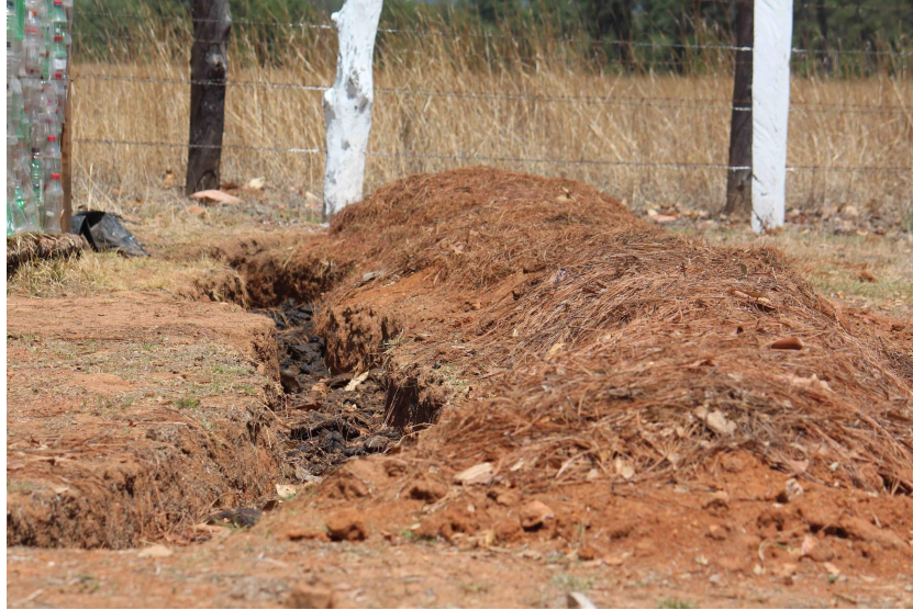
Excavación de zanja.
