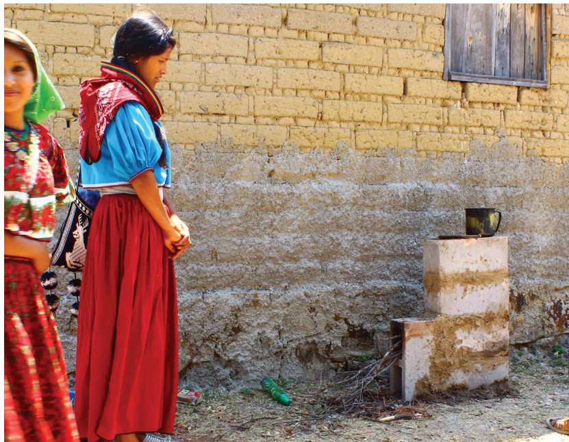
Construcción de estufa eficiente.
