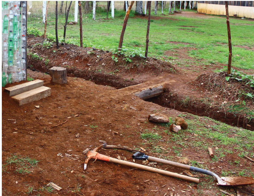
Construcción de puente y mobiliario.
