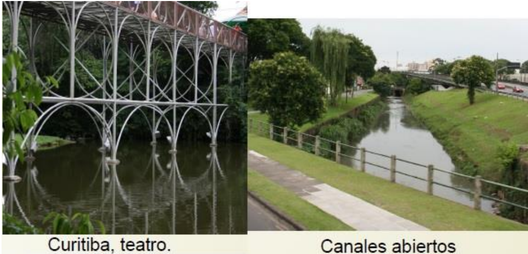
Fotografía 4. Canales anchos para control de crecidas de taludes con vegetación en Curitiba, Brasil. Fuente: Perlo, M. (2013)
