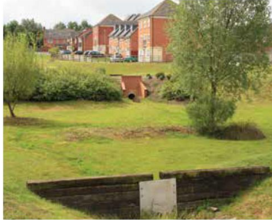
Fotografía 13. Fotografía de opción de vertedor mediante muro sencillo de mampostería apoyado de una lámina o tabla. Fuente: CIRIA (2015).
