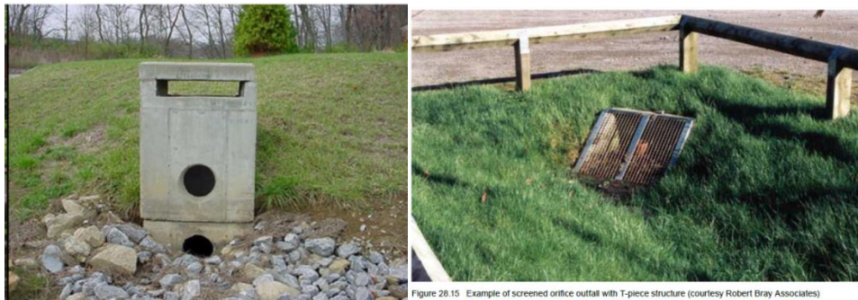
Fotografía 12. Fotografía de opción de vertedor para sistemas de detención (izquierda) y salida con filtro de basuras en cuneta verde (derecha). Fuente: Manual de soporte de xpdrainage y CIRIA (2015).
