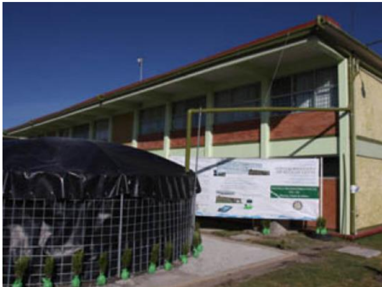
Fotografía 8. Cisterna exterior en Metepec, Estado de México. Fuente: Perlo, M. (2013).
