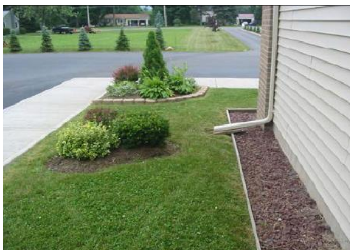
Fotografía 10. Foto de una desconexión de azotea hacia un jardín de lluvia. Fuente: New York State Stormwater Management Design Manual.
