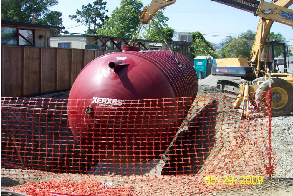
Fotografía 6. Fotografía del momento en que se está colocando la cisterna de aguas pluviales en una excavación. Fuente: Sherwood Design Engineers (sf).
