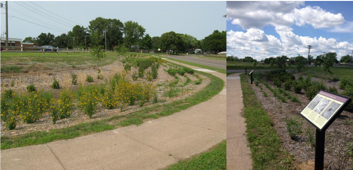
Fotografía 2. Fotografías de los jardines de lluvia en la secundaria Fridley Middle School y el parque con lago West More Lake Park han sido instrumentales reduciendo la carga de fósforo y sedimentos que van hacia el Lago de West Moore, a la vez reduciendo las inundaciones. Fuente: ricecreek.org
