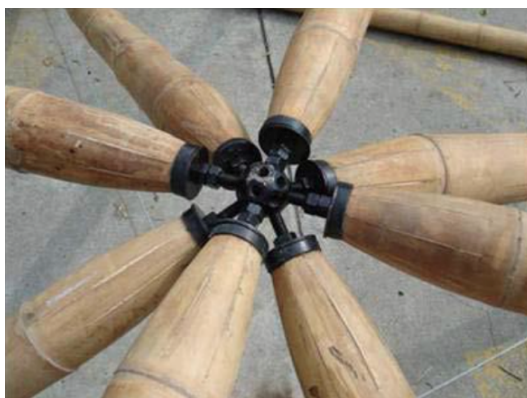
Unión cónica con esfera, J. Stamm. Fuente: bambumex.org
