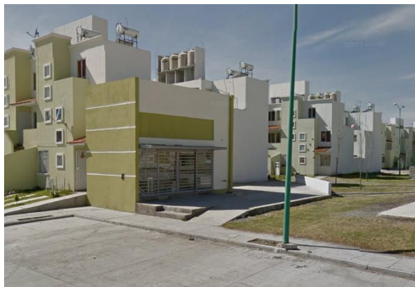
Figura 32: Locales comerciales al interior de las zonas habitacionales; Fotografía propia.
