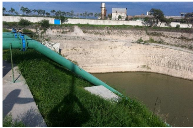
Figura 25: Pozo de captación de agua pluvial; Fotografía propia.
