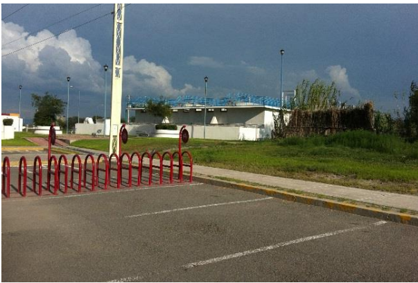
Figura 24: Planta de tratamiento de aguas negras; Fotografía propia.
