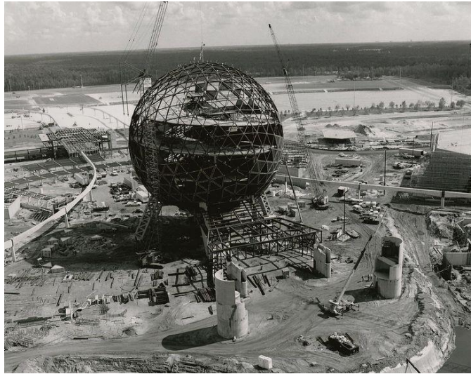
Construcción de Spaceship Earth a finales de 1970.
