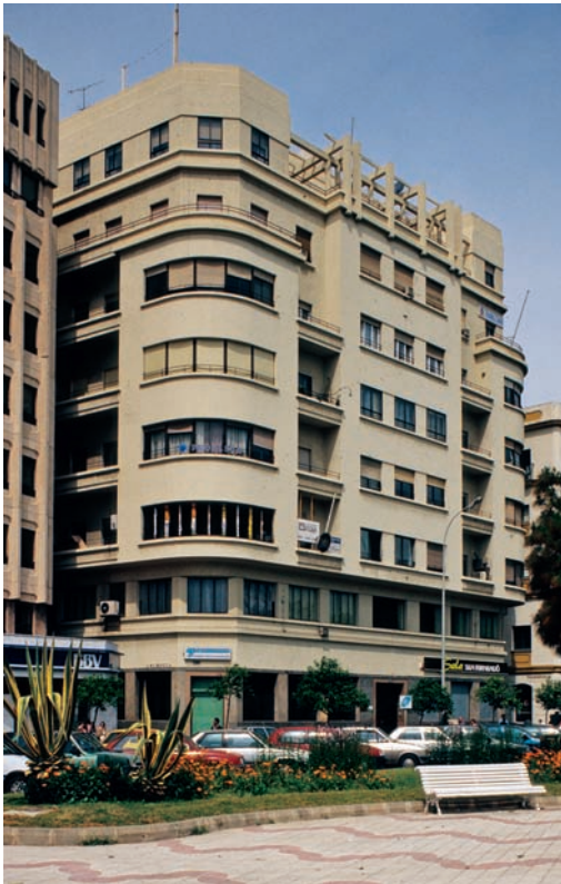
13. Edificio de la Compañía Transmediterránea, Cádiz. IAPH
