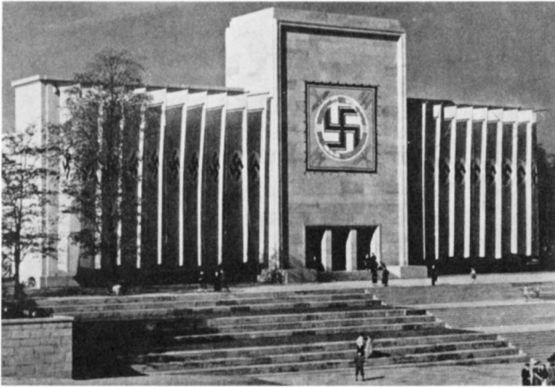
Fig. 8. Speer, Luitpoldhalle, Nuremberg (from Rittich, Architektur und Bauplastik der Gegenwart ).
