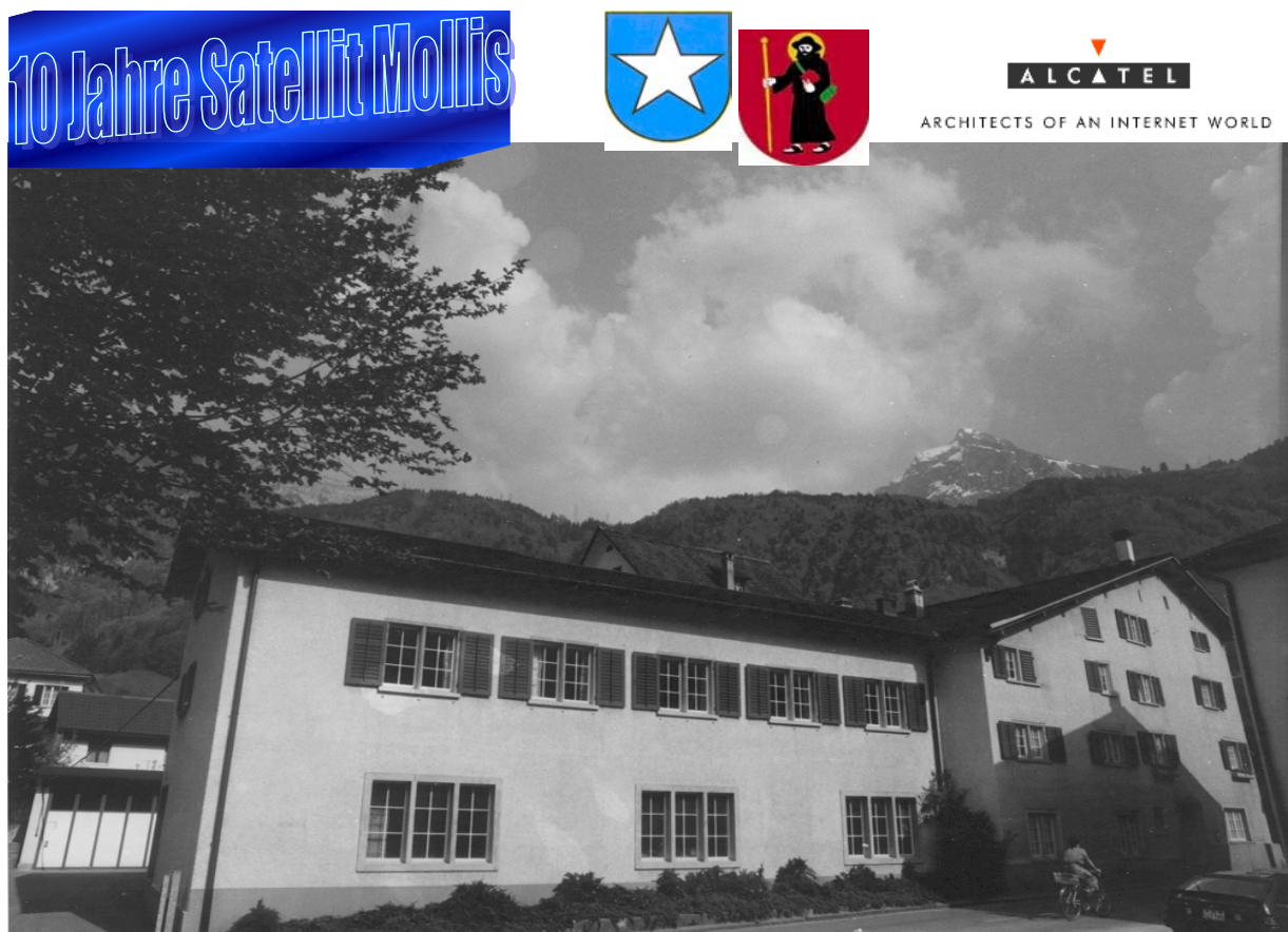
Abbildung 79: Gebäude des Alcatel Satellitenbüros im Dorf Mollis GL 101
