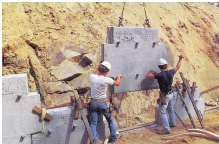
Il y a lieu d'être très prudent dans ce domaine et de ne pas suivre ceux qui prétendent, par exemple, qu'on peut utiliser des argiles avec des renforcements en nappes. Dans les conditions usuelles de chantier, la mise en œuvre, le compactage et la stabilité des remblais de matériaux fins, renforcés ou non, reste toujours critique.
