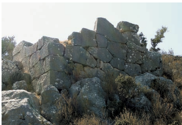
Fig. 11 : Xanthos: polygonales Mauerwerk an einem Turm nördlich des Nordosttores (Foto: O. Hülten).
