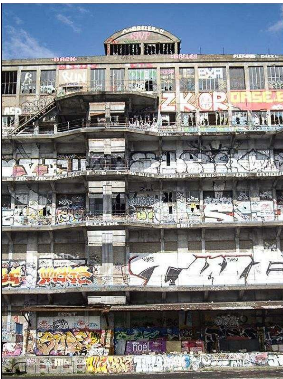
Illustration 1 - Le bâtiment des douanes en 2011
