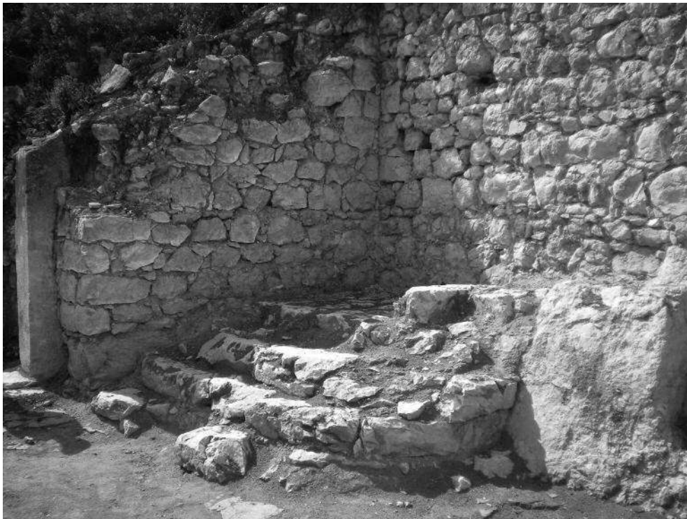
Fig. 5 : Escaliers dans l'angle sud-ouest du narthex.
