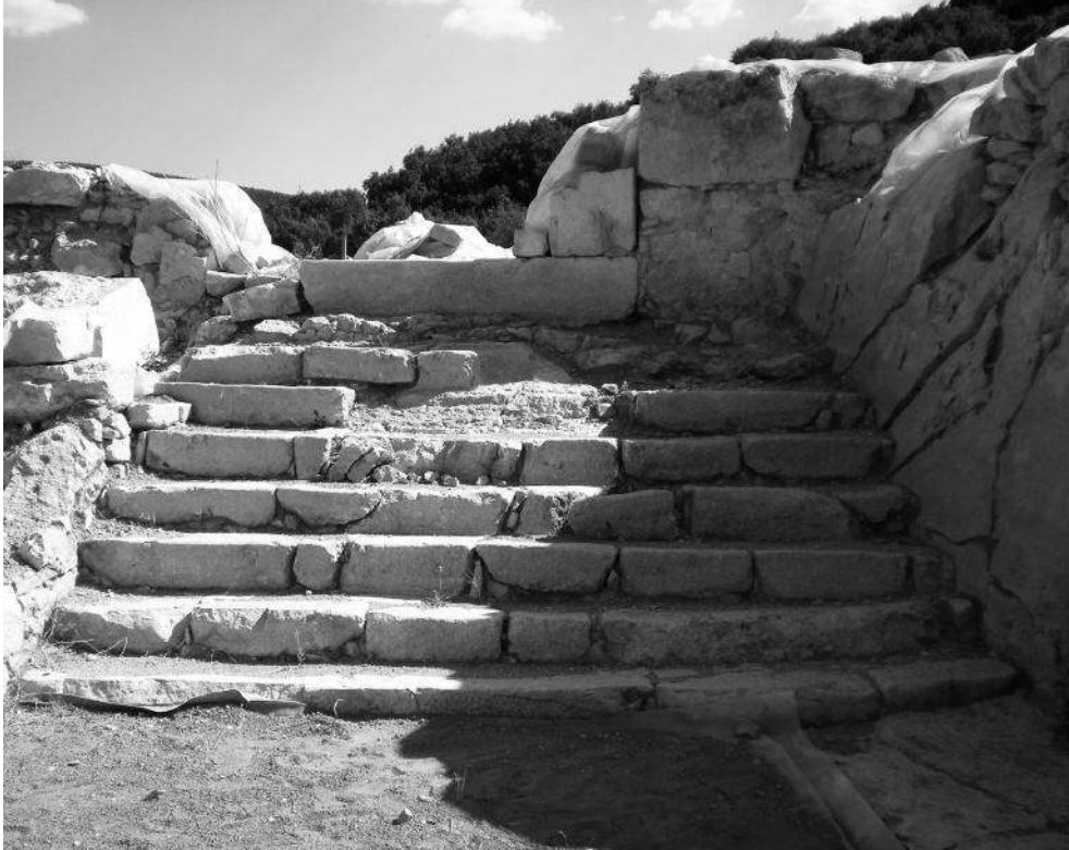
Fig. 7 : L'entrée sur le bas-côté nord de l'église.
