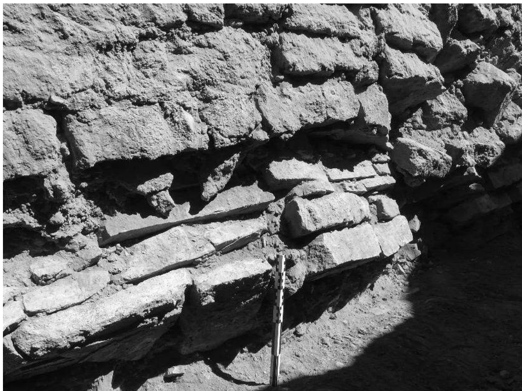
Fig. 16 : Sommet du soubassement de pierres au-dessus du logement d'une longrine. Vue vers le Nord-Est.
