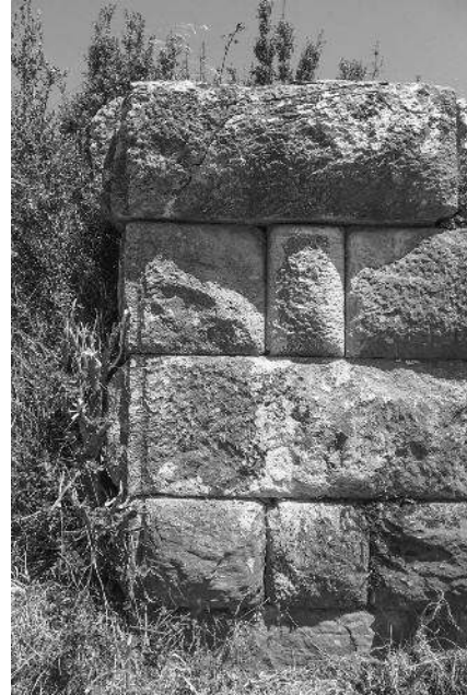
Fig. 17 : Décrochement, angle avec plumée et double boutisses (cliché B. Vergnaud).
