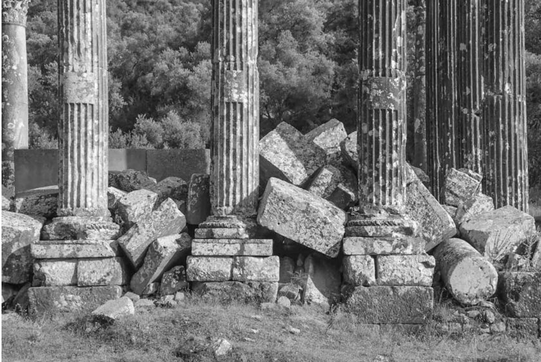
Fig. 20 : Fondations de la colonnade nord du temple.
