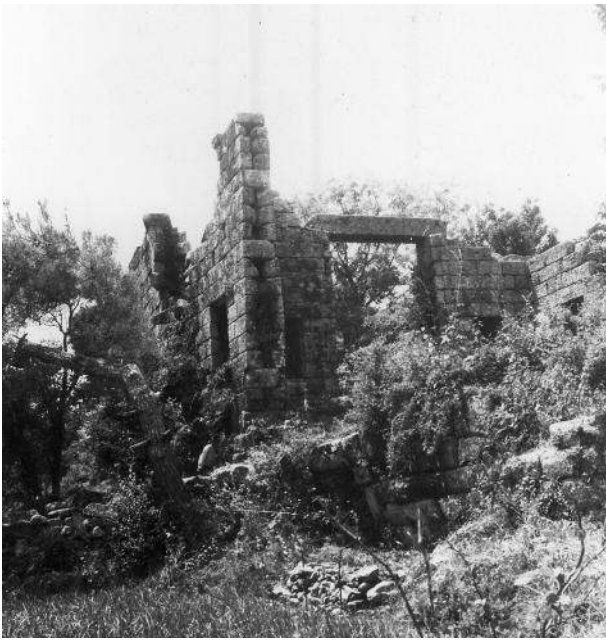
Fig. 50 : Vue générale de l'Andron A depuis le Sud-Est, en 1948 (archives).
