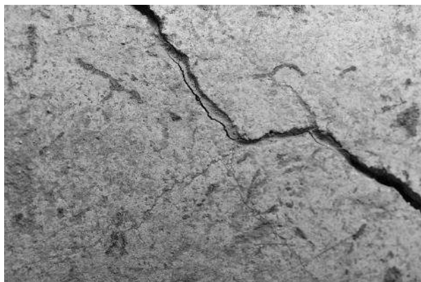
Fig. 87 : Enduit de finition du sol original de l' Andron A (O. Henry).
