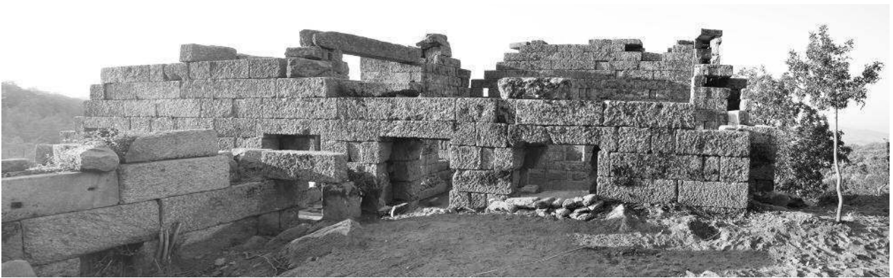
Fig. 67 : La face nord de l' Andron A , après l'opération de 2014 (O. Henry).
