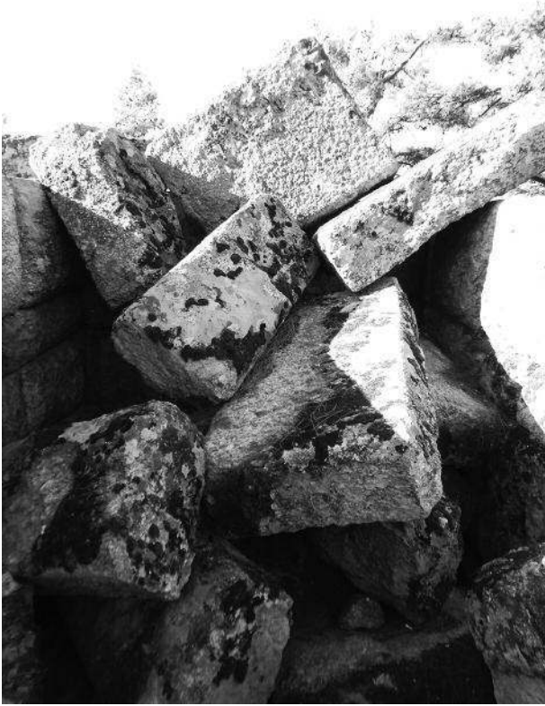
Fig. 25 : Tour pentagonale. Chambre ouest avant la fouille (vers le Sud) (B. Vergnaud).
