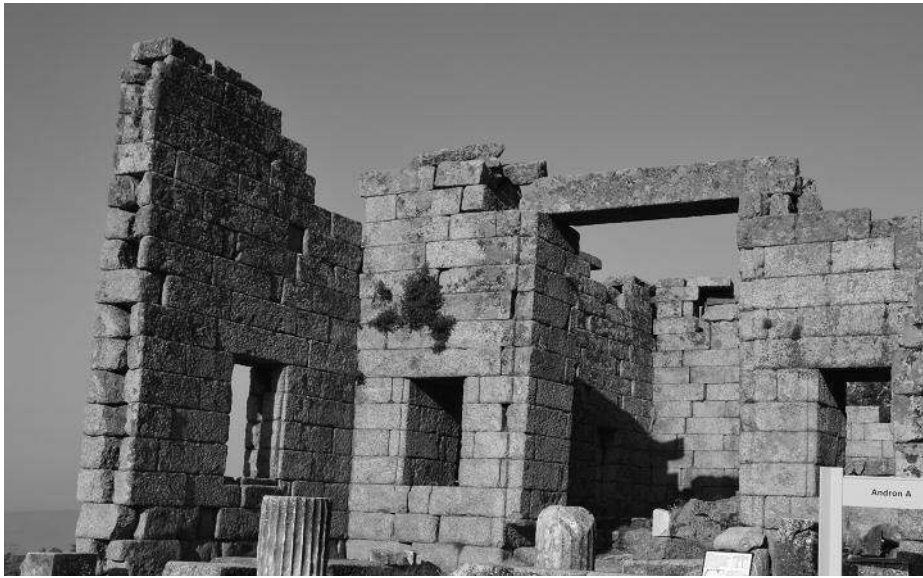
Fig. 48 : Vue de la façade de l'Andron A, depuis l'Est (O. Henry).
