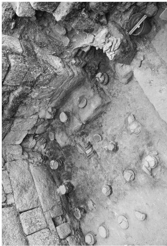
Fig. 107 : Pilettes de l'hypocauste en partie arasées et niveau de cendres (US 1021) dans la pièce PCE1 (Chr. Bost).
