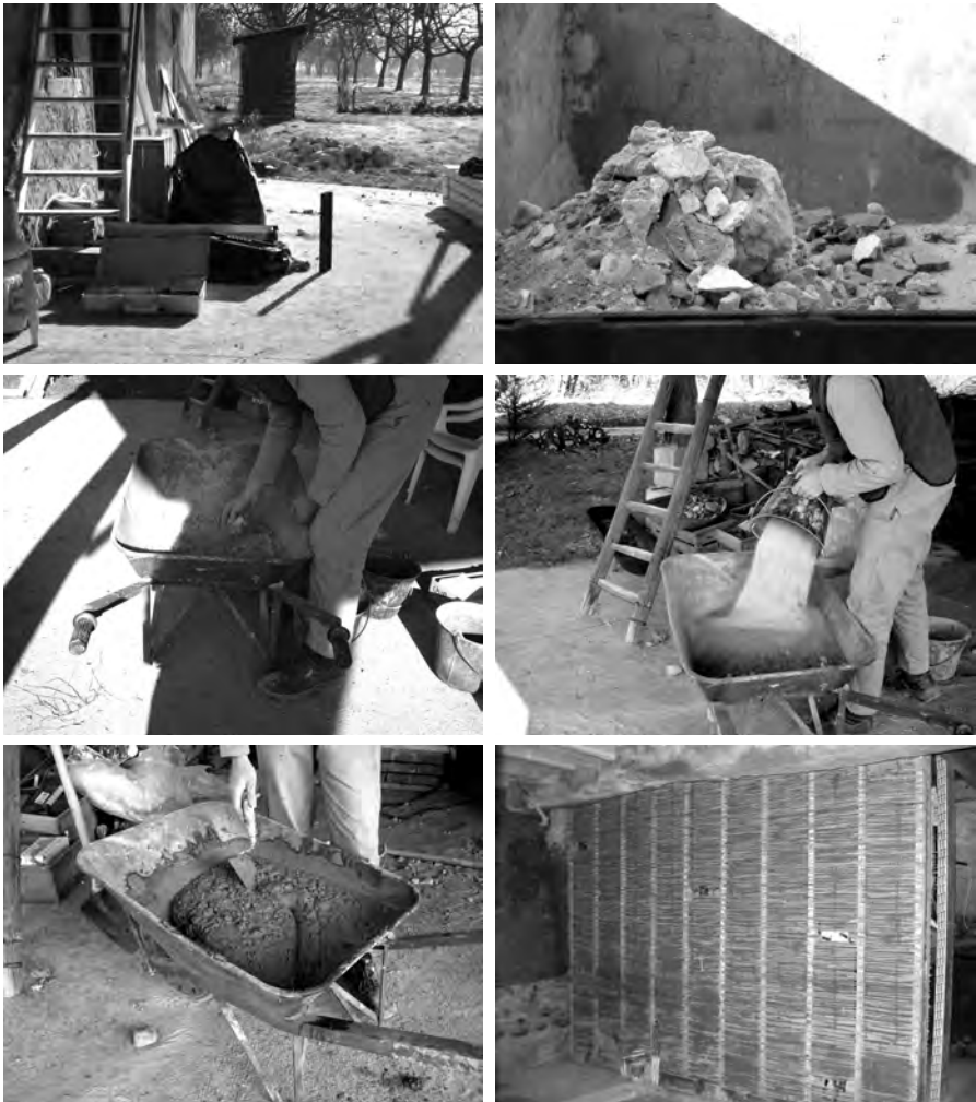
Figure 2. Préparation de la mise en œuvre de la terre sur un chantier de réhabilitation d'une ancienne ferme
