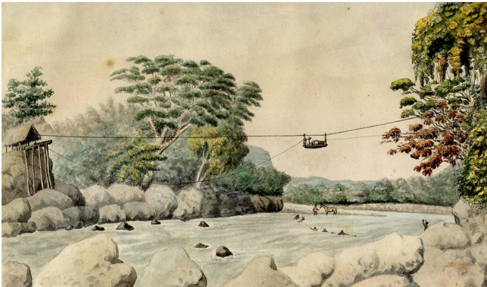
Fig. 1. – Aquarelle de Carmelo Fernandez : Cabuya de Simacota sobre el Sarabita , 1850, téléphérique en cordes de Cabuya au-dessus de la rivière Sarabita, près de Simacota (Socorro, province de Santander, Colombie).
