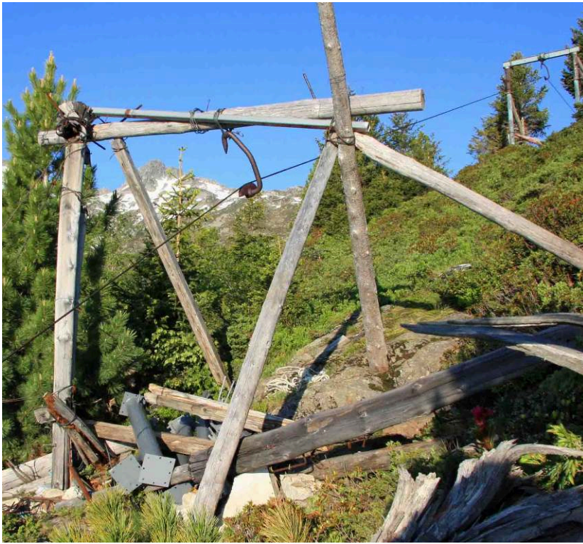
Fig. 4. – Alpage d'Arpingon, à Saint-Rémy-de-Maurienne (Isère), ancienne « cabrette » en bois supportant le câble porteur au moyen d'une « pipe » : installation typique des téléphériques agricoles anciens.
