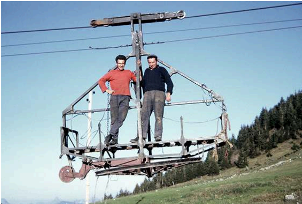
Fig. 6. – Ancien téléphérique multifonctions de Thollon-les-Mémises en 1968 : boilles de lait à la descente, provisions et bois pour les alpagistes à la remontée. On aperçoit sous la nacelle une poulie destinée au montage d'un télési.
