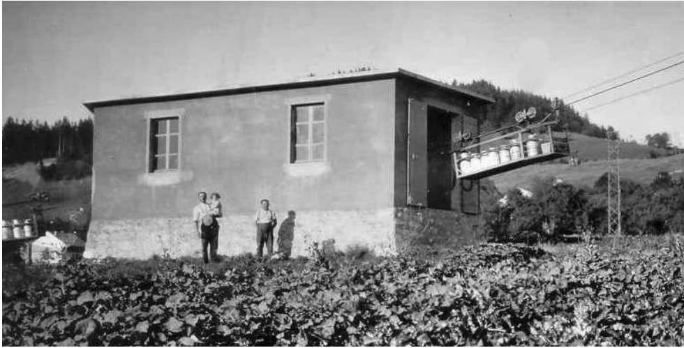
Fig. 5. – Transport de lait à Bogève (Haute-Savoie) : arrivée à droite de deux câbles à la station intermédiaire (la cabane des Mouilles) avant descente à la fruitière par le câble de gauche.
