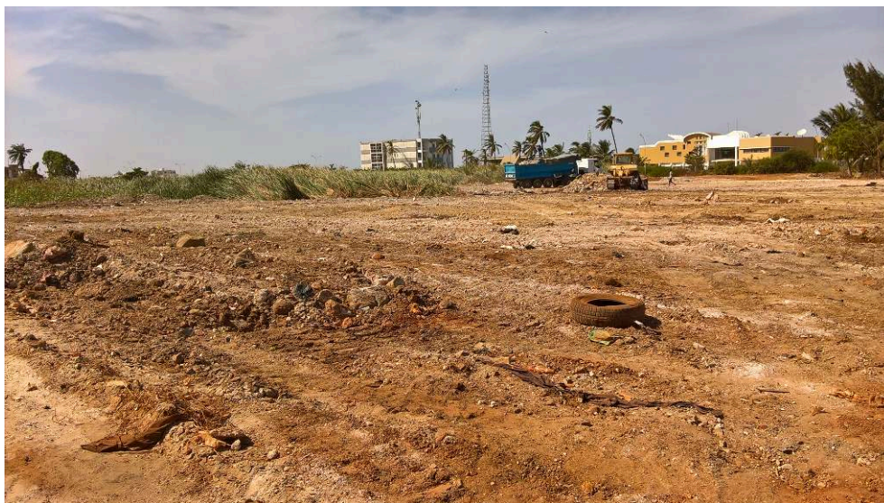
Figure 9. Remblai d'une ancienne exploitation au Technopôle.
