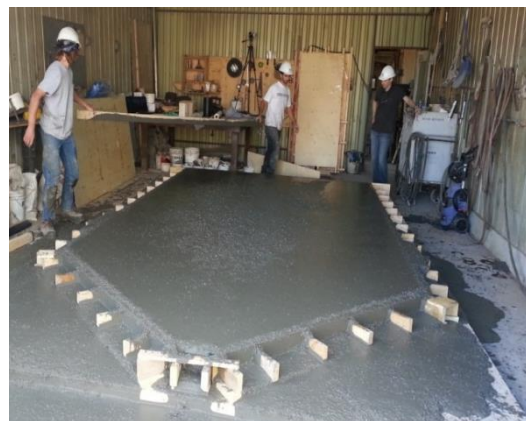
Figure 3-5: Coulé du béton en deux étapes, a) Schéma, b) Photos
