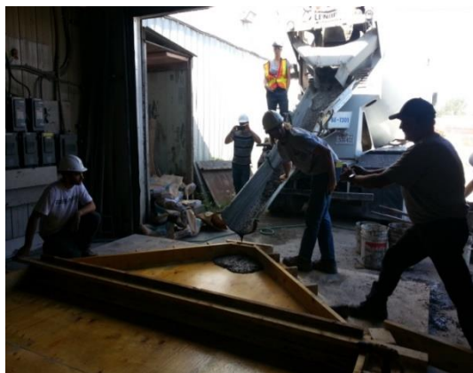
Figure 3-5: Coulé du béton en deux étapes, a) Schéma, b) Photos
