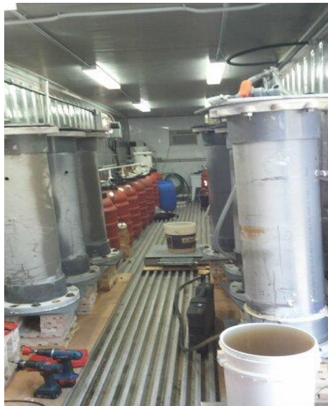
Figure 3-4 - Colonnes et les barils remplis avec les scories dans le conteneur pilote
