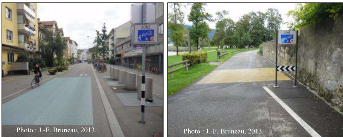
Figure 2.1 : Porte d'entrée : (à gauche Berne, Suisse ; à droite Aarberg, Suisse)
