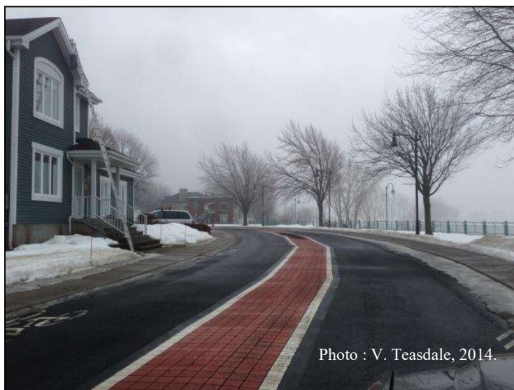
Figure 7.40 : Bande centrale composée de tuiles thermoplastiques (Varennes, Québec)
