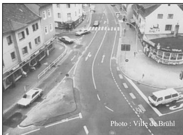
Figure 7.29 : Avant le carrefour giratoire : gestion par feux (Brühl, Allemagne)
