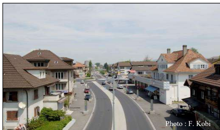
Figure 7.4 : La Schwarzenburgstrasse (nord) après le réaménagement (Köniz, Suisse)
