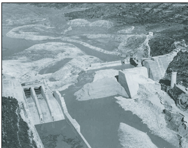
Figure 4-29 : Vestiges du barrage de Tous après la catastrophe (Alcrudo & Mulet, 2007)
