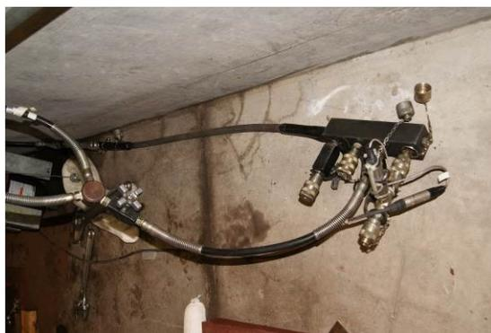
Multiplicateur hydraulique et valve hydraulique de contrôle des vérins (Subdivision 4)
