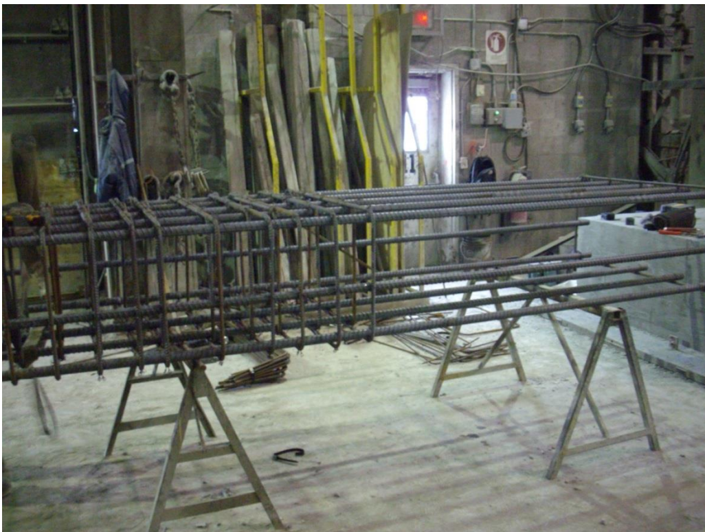
Photo 9 : Montage de l'armature de la pile S6 (4 oct.)
