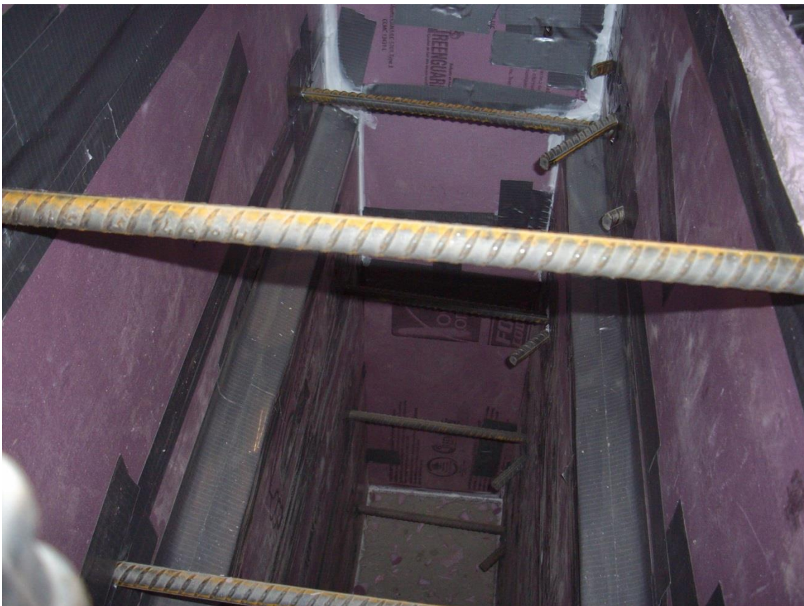
Photo 2 : Vue de l'intérieur de la pile (10 sept.)
