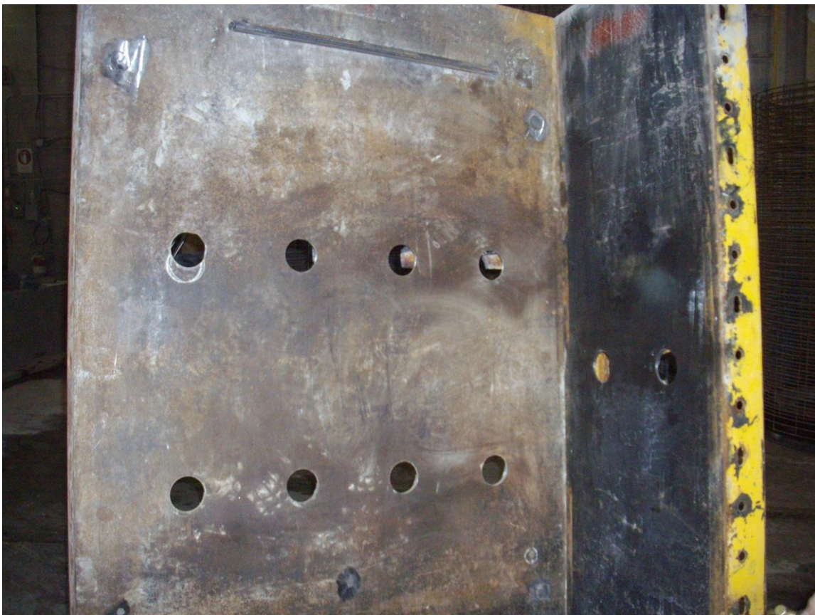
Photo 4 : Trous dans le coffrage en acier pour supporter les tubes de PVC (14 sept.)
