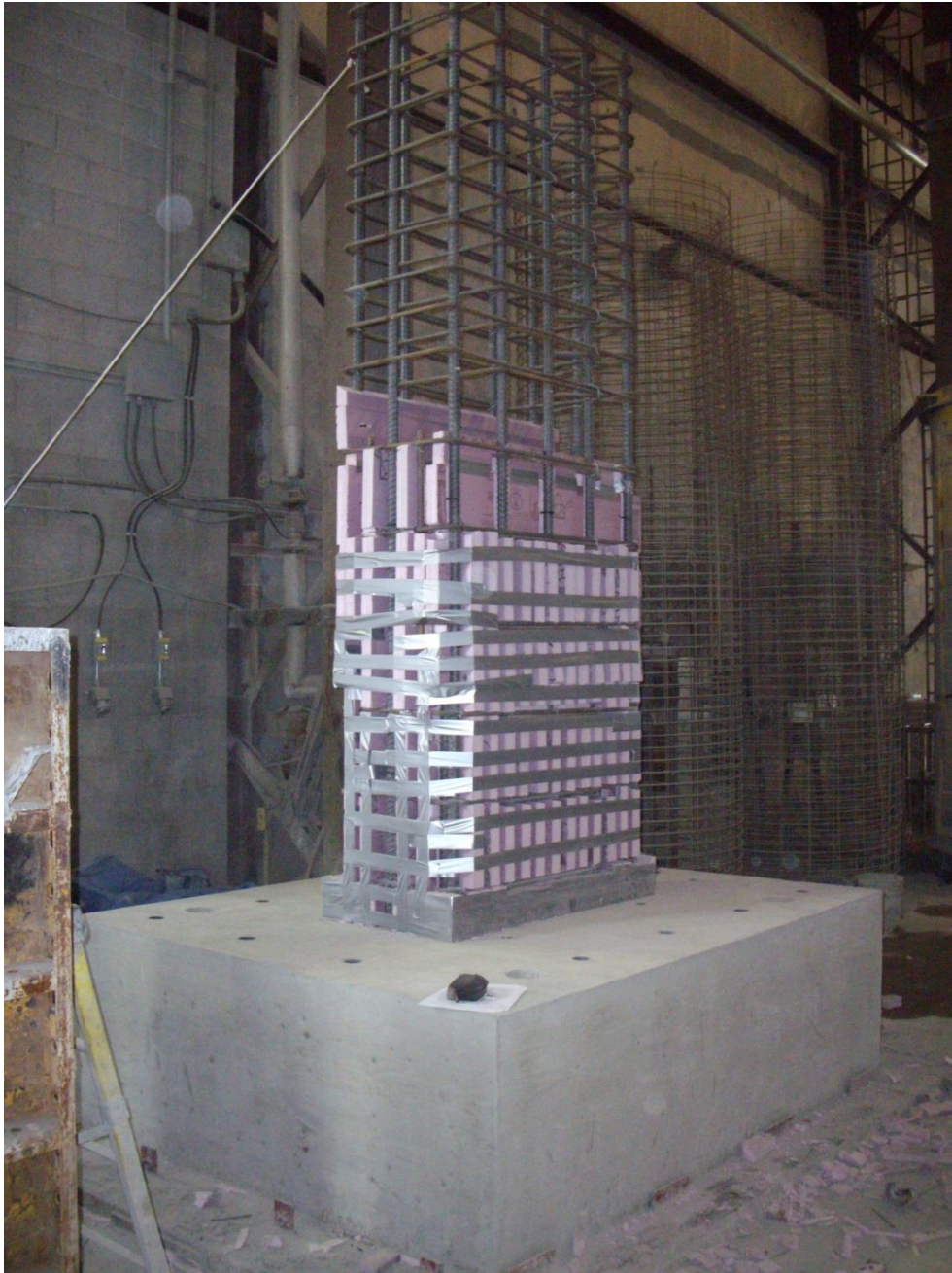
Photo 3 : Installation du styromousse presque terminée (10 sept.)
