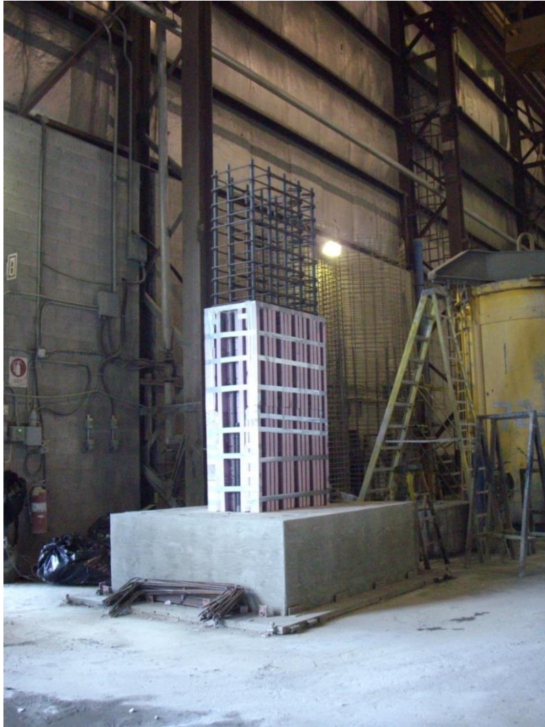
Figure 3.6 : Pile avant la mise en place du coffrage
