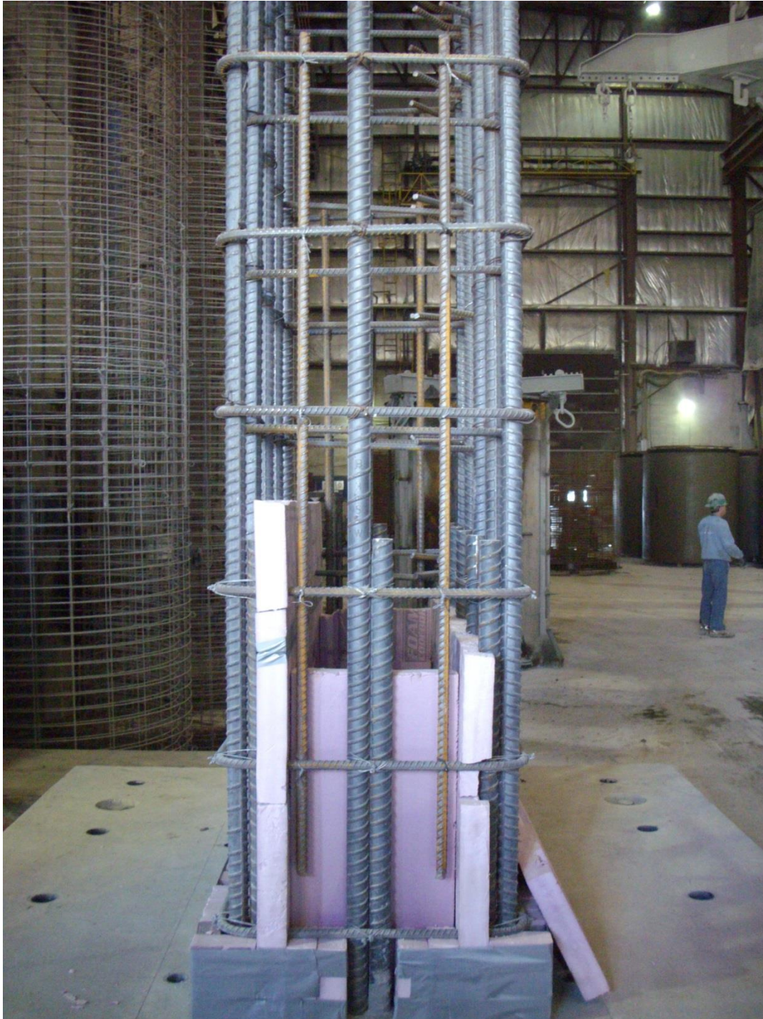
Photo 1 : Début de l'installation du styromousse (10 sept.)
