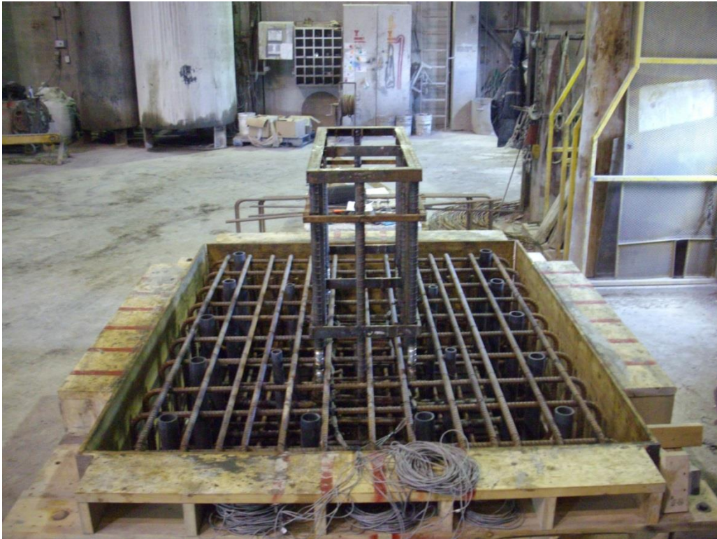
Photo 8 : Montage de l'armature de la semelle S6 (27 sept.)
