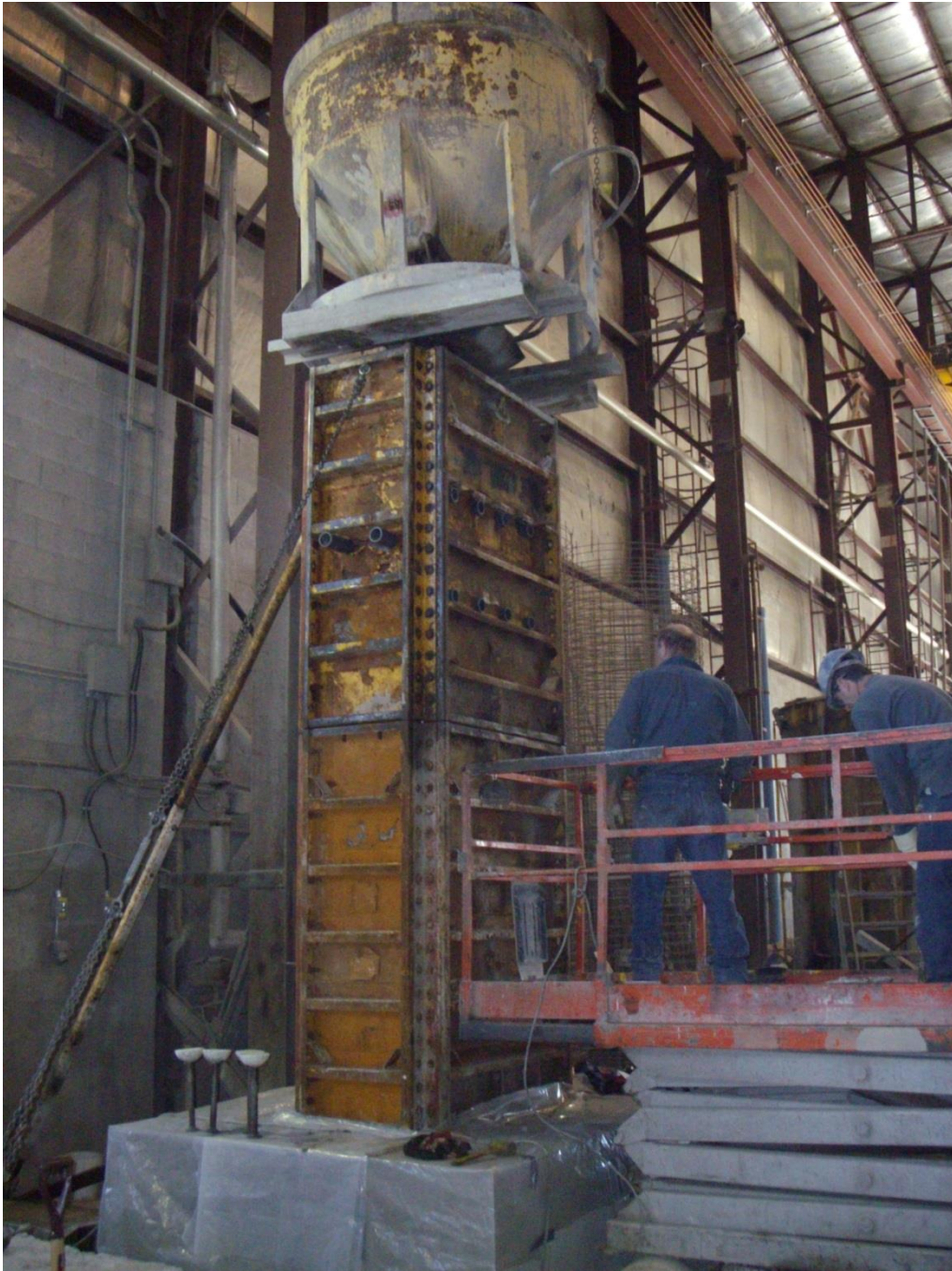
Photo 2 : Coulée de la pile S5 (17 sept.)
