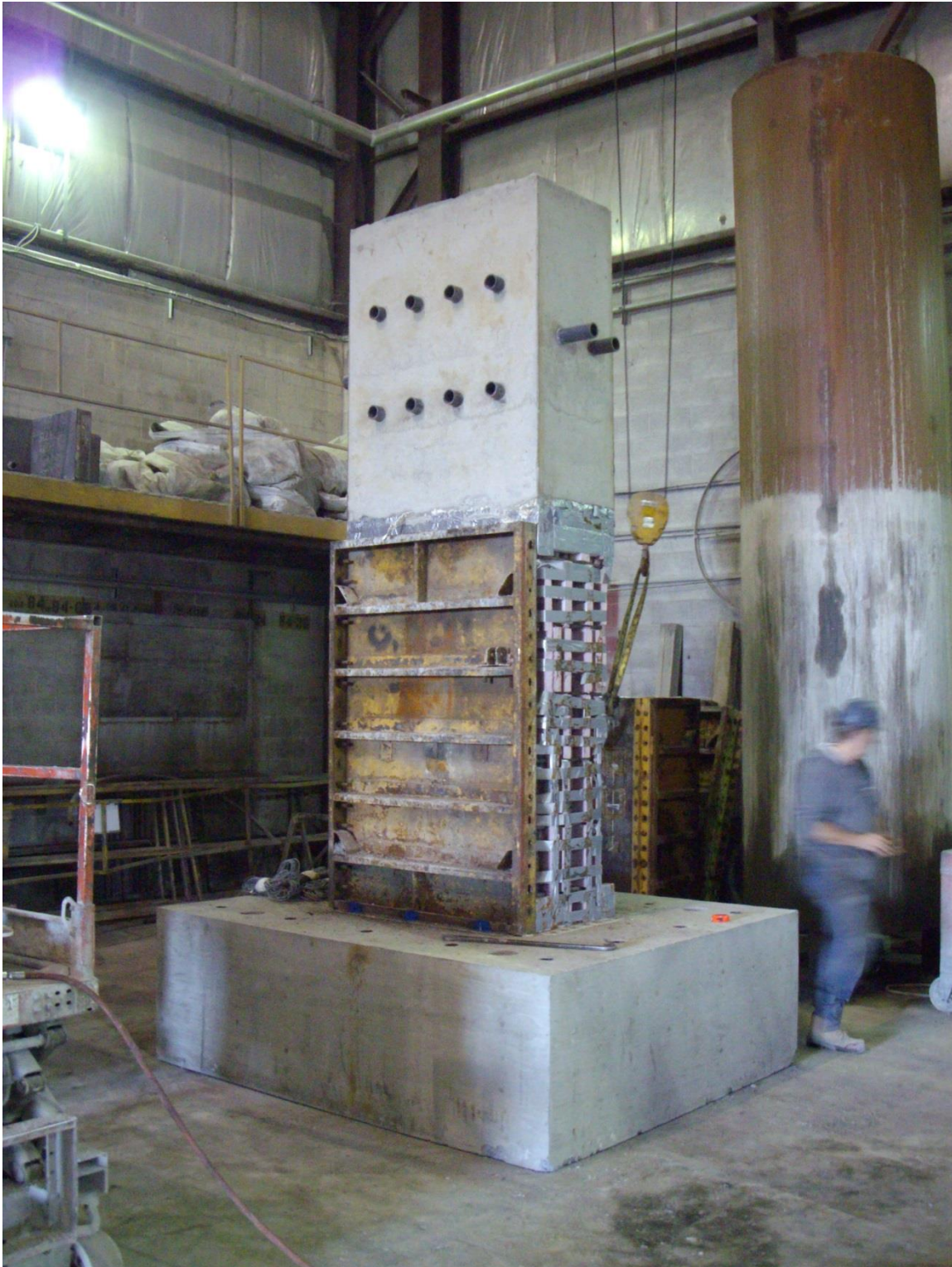
Photo 4 : Décoffrage de la pile S5 à son nouvel emplacement (23 sept.)
