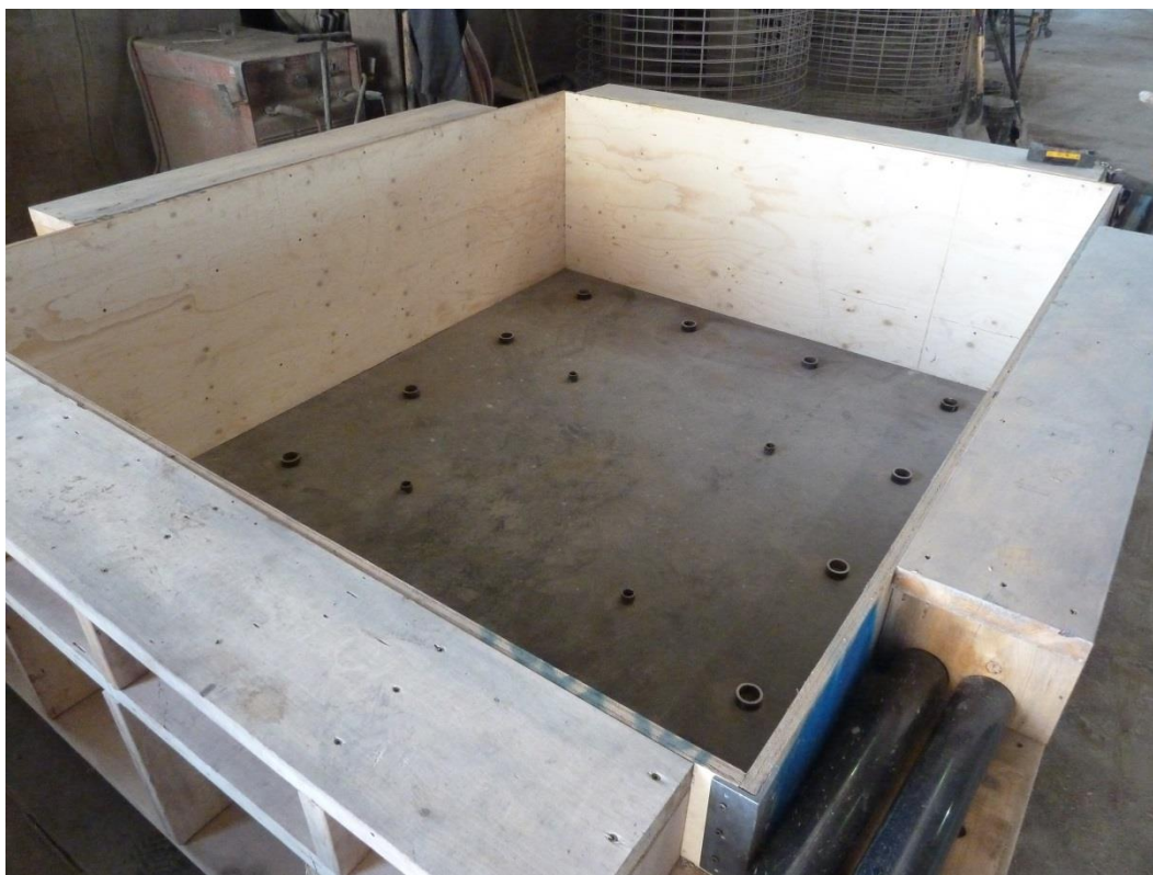
Photo 1 : Positionnement des rondelles d'acier dans le fond du coffrage (30 juil.)
