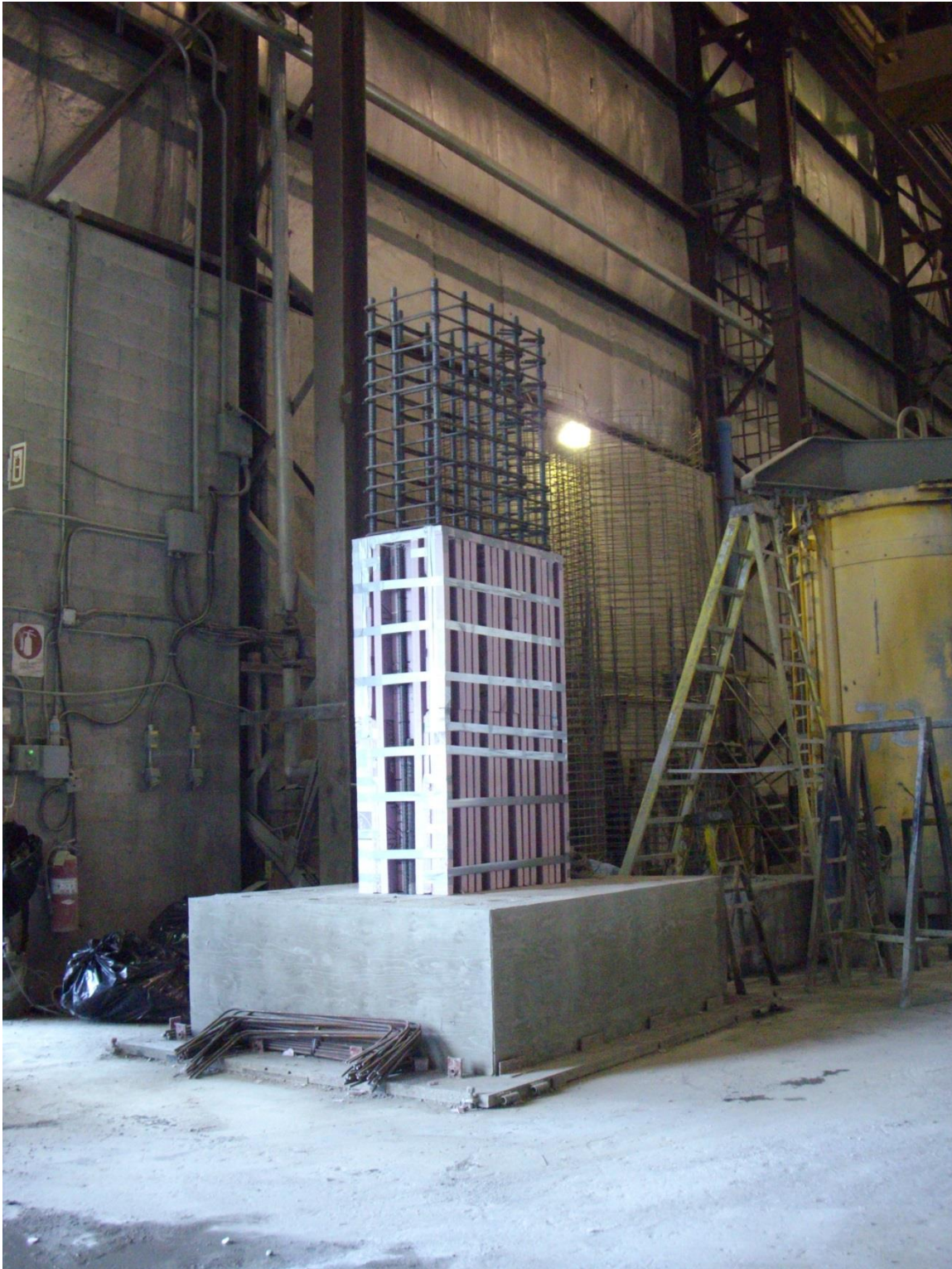
Photo 11 : Installation du styromousse sur la pile S6 (8 oct.)
