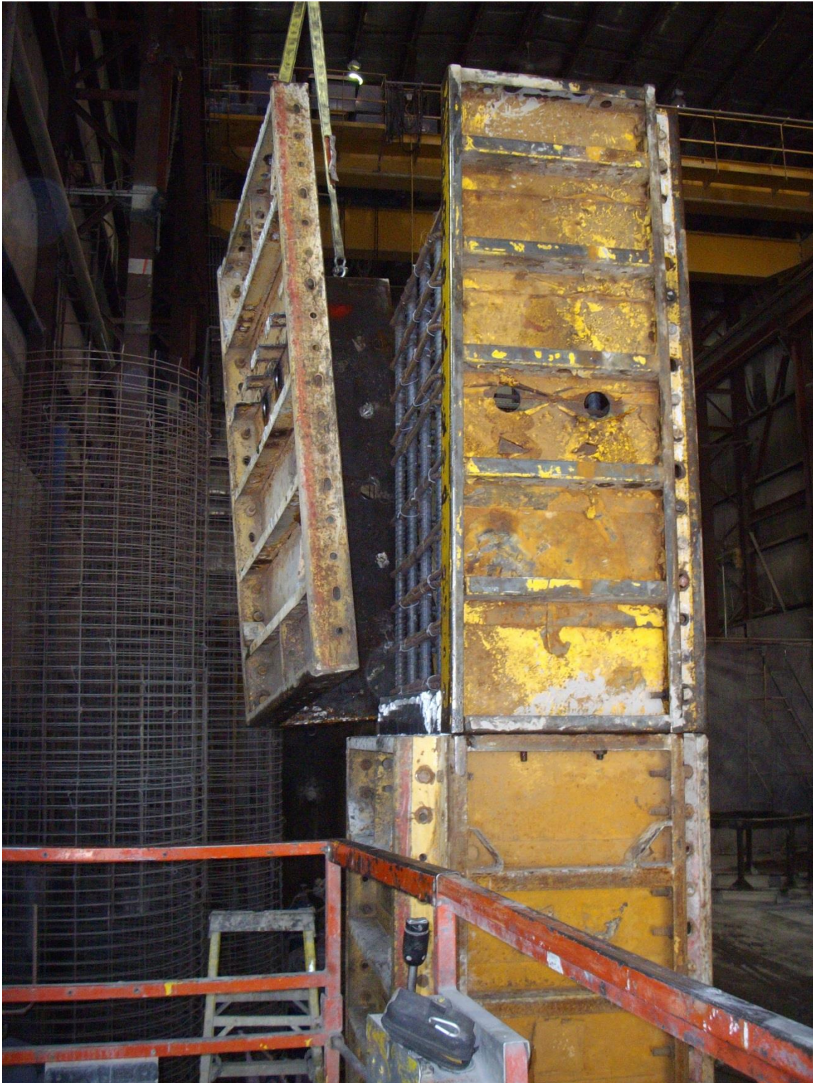
Photo 6 : Installation du coffrage en acier (partie du haut) (14 sept.)
