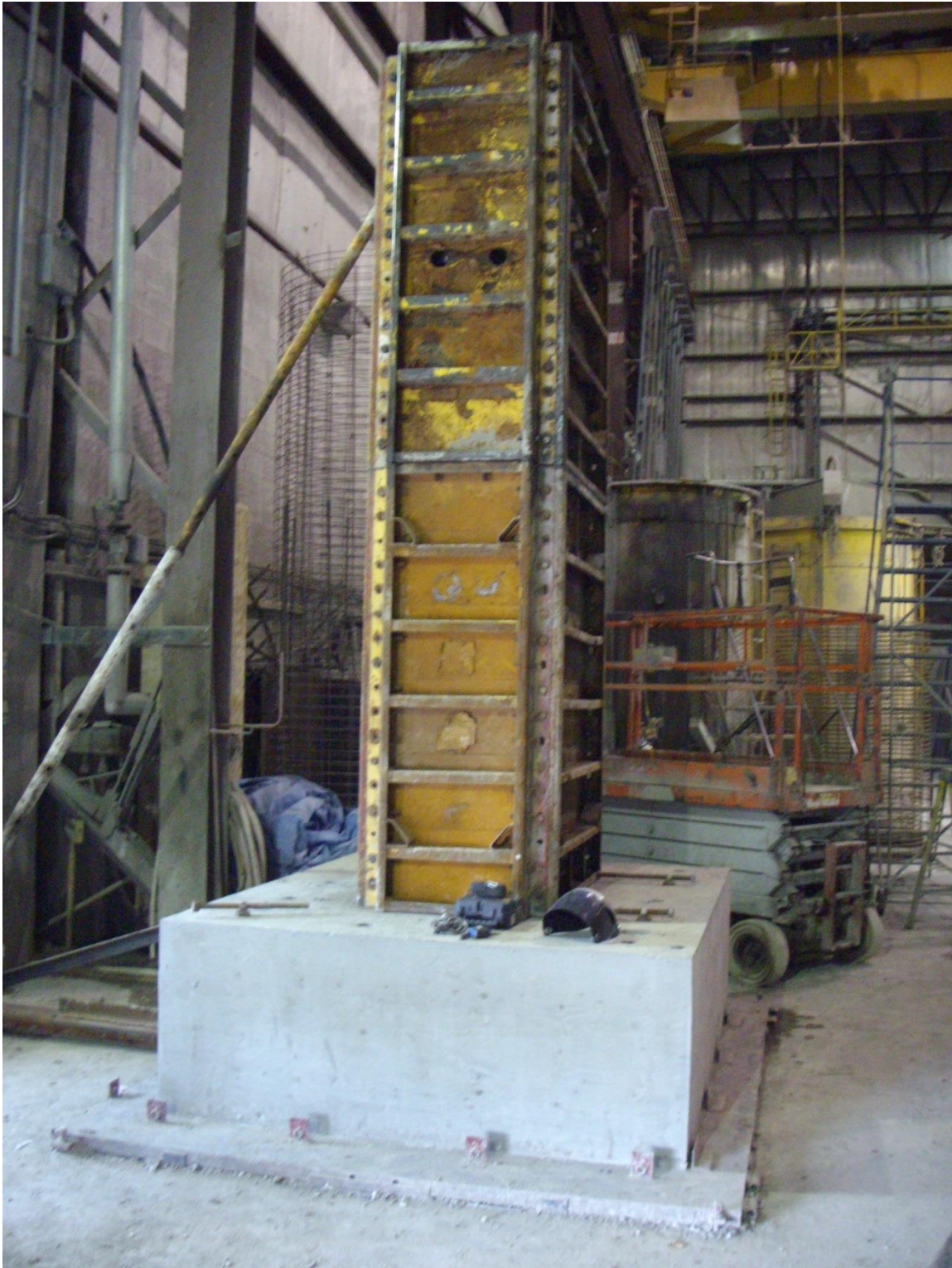
Photo 7 : Coffrage en acier complété (14 sept.)
