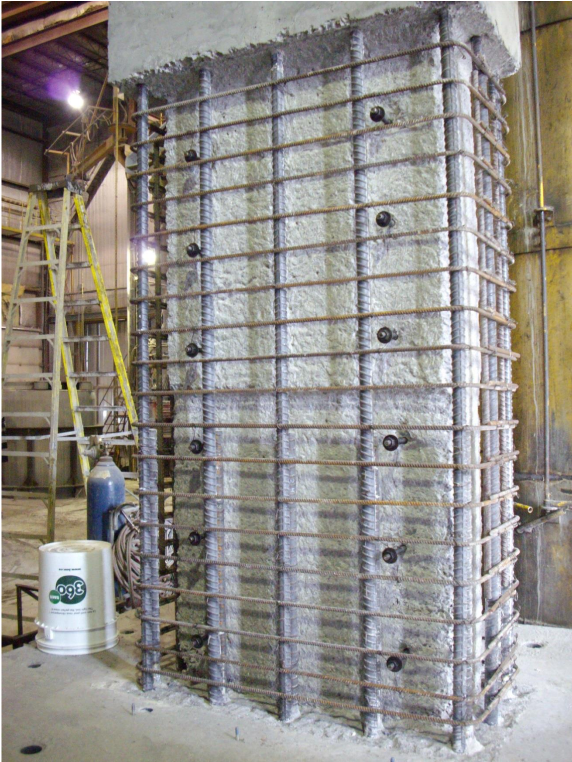
Photo 6 : Allure de la pile S6 avant l'application du renforcement en BFUP (25 oct.)
