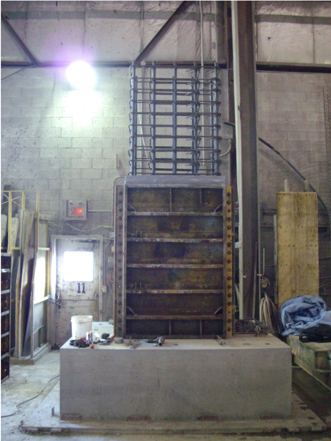
Photo 5 : Installation du coffrage en acier (partie du bas) (14 sept.)
