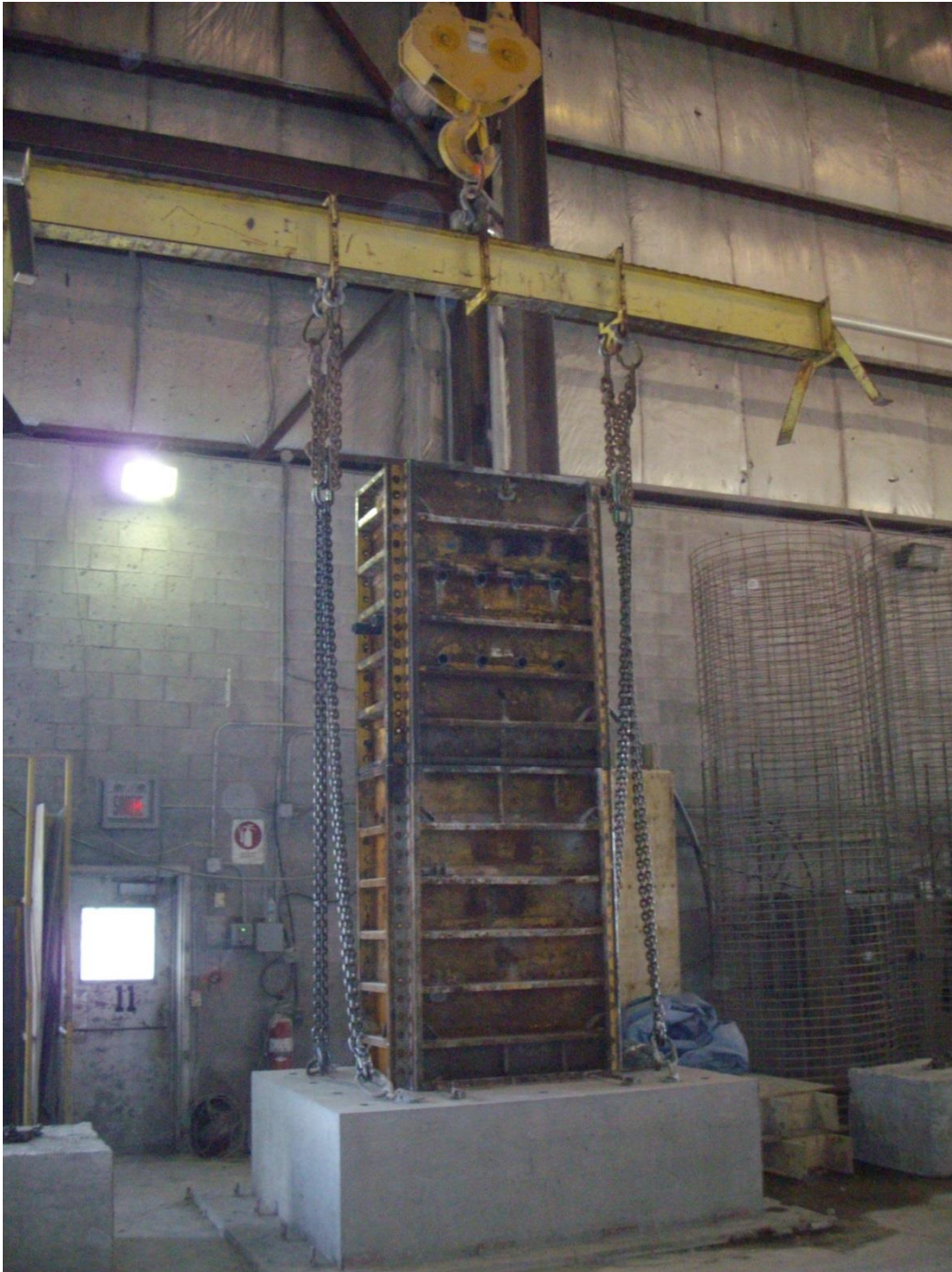
Photo 3 : Déplacement de la pile S5 (20 sept.)
