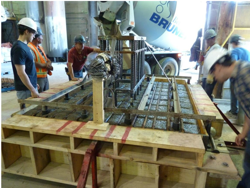
Photo 8 : Coulée du béton de la semelle S5 (12 août)
