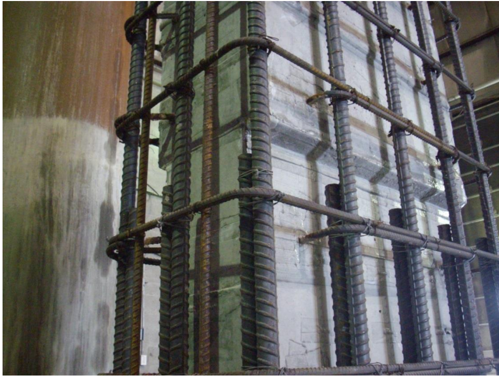
Photo 5 : Zone de réparation après décoffrage (23 sept.)
