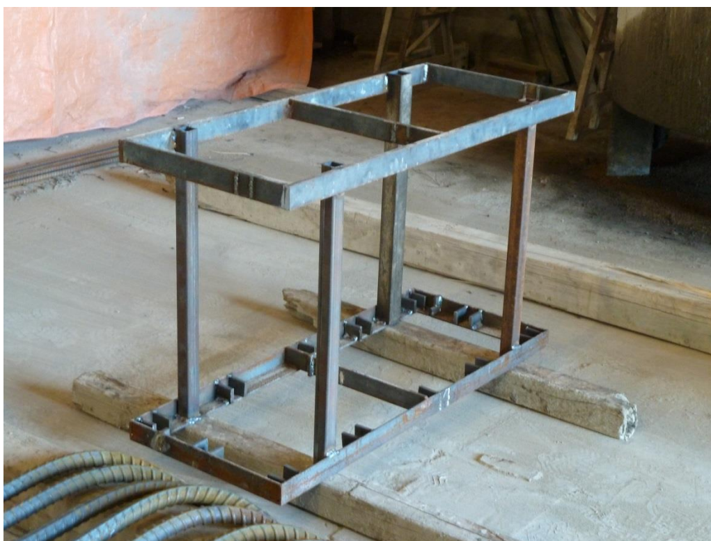
Photo 3 : Support servant à bien positionner les barres jaugées (5 août)
