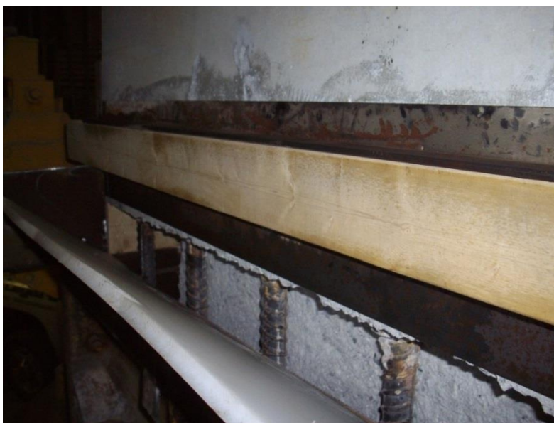
Figure 3.10 : Ouverture au haut du coffrage permettant de terminer la coulée du BFUP
