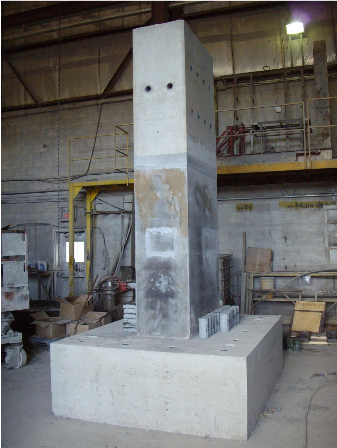
Photo 4 : Pile S5 décoffrée (25 oct.)
