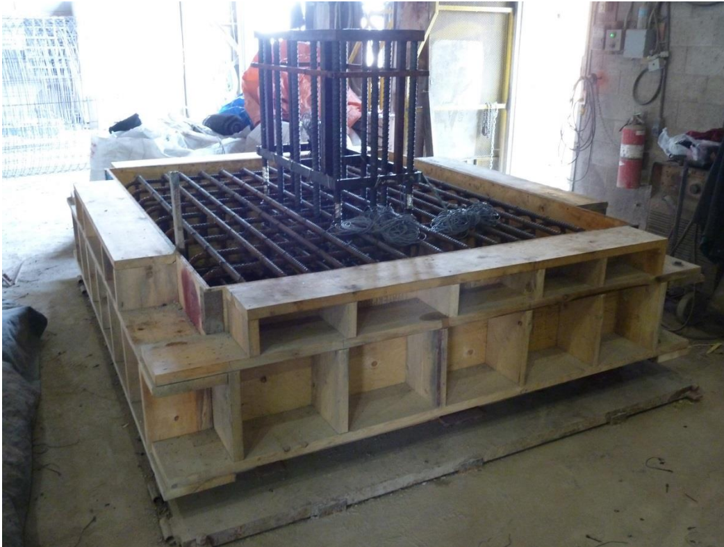
Photo 6 : Fermeture de la cage d'armature de la semelle (7 août)
