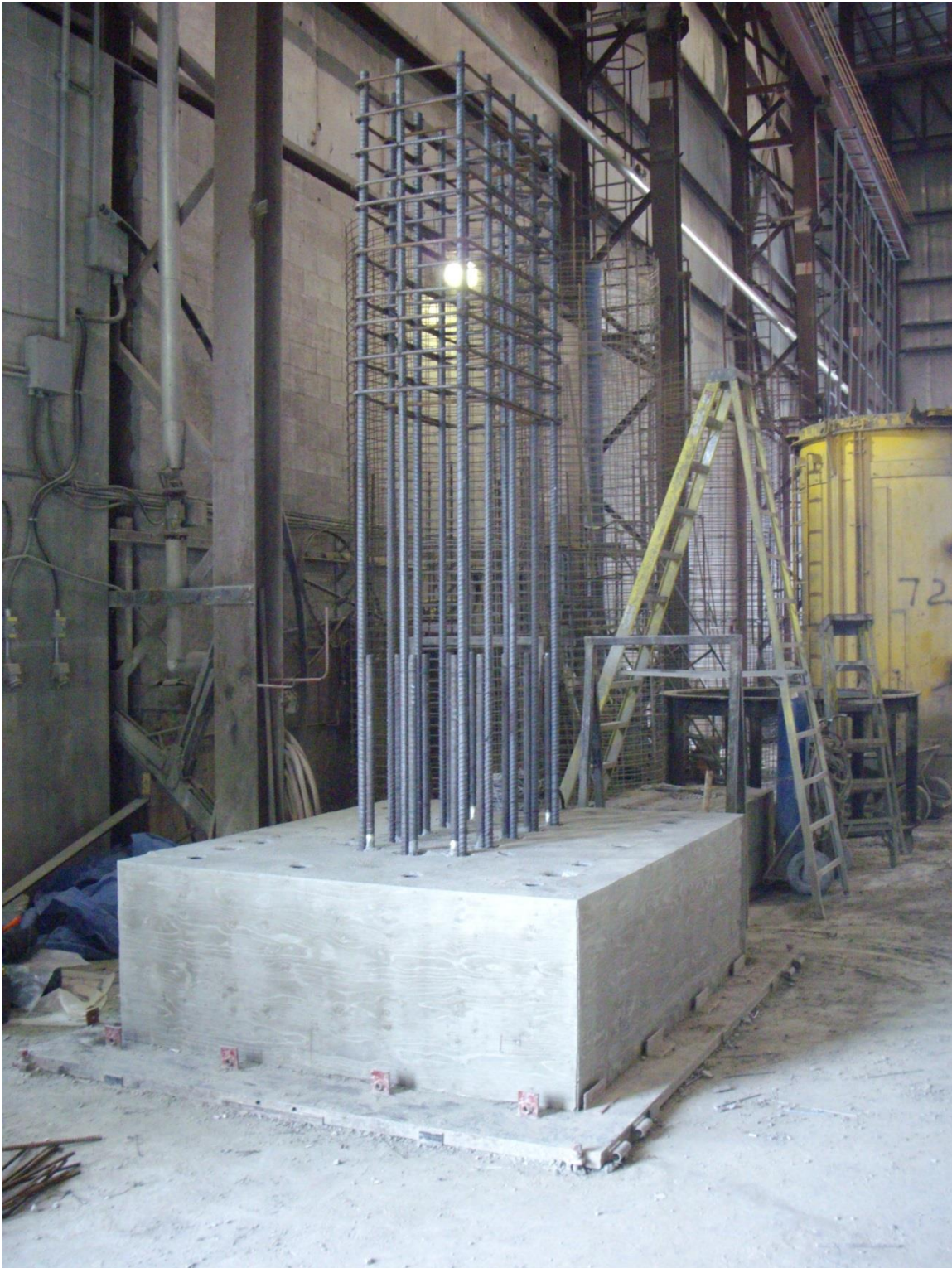
Photo 10 : Mise en place de la cage d'armature sur la semelle S6 (4 oct.)
