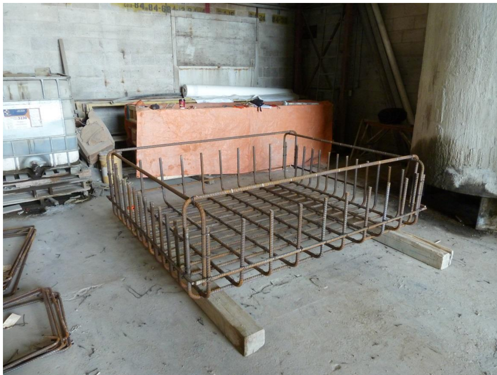
Photo 2 : Début du montage de l'armature de la semelle S5 (2 août)
