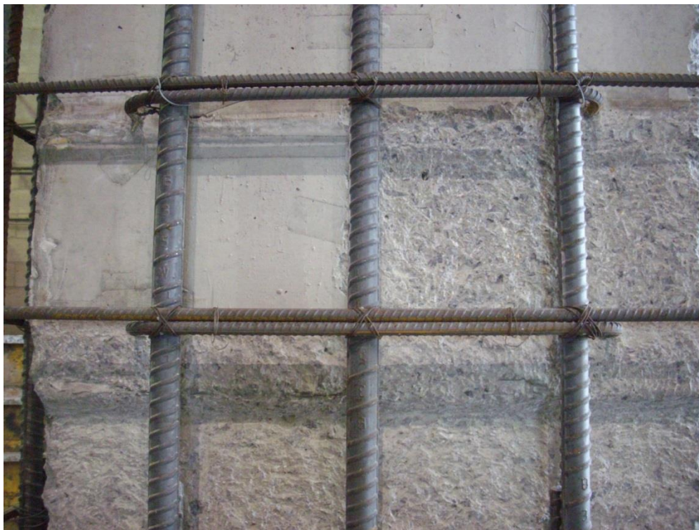
Photo 6 : Surface non-martelée (gauche) et surface martelée (droite) (1 er oct.)
