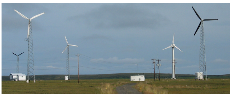
Figure 3.2 Éoliennes de type AOC 15/50 tour monobloc ou treillis à Kotzebue, © Wikimedia.
