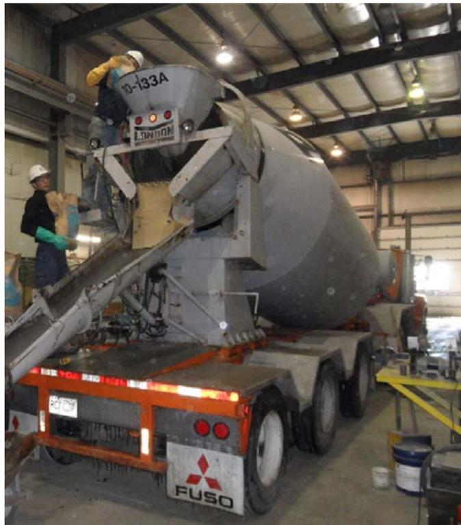
Figure 4-15 : Insertion des fibres dans le camion-toupie
