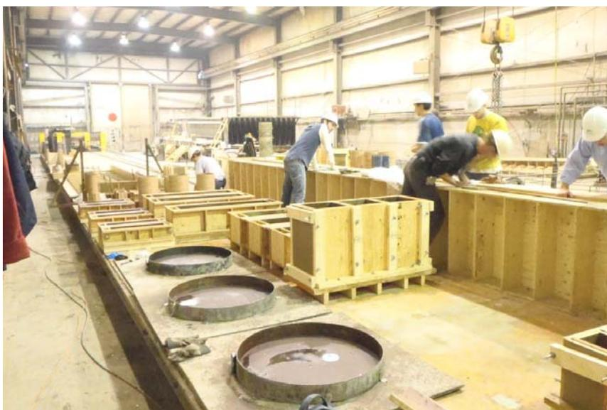
Figure 4-12 : Photographie de l'inspection des coffrages
