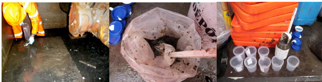
Figure 2.3 Échantillonnage des sédiments d'une chambre d'aqueduc
