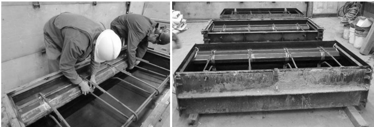
Figure 5-16: Precast Barrier Pour Preparation
