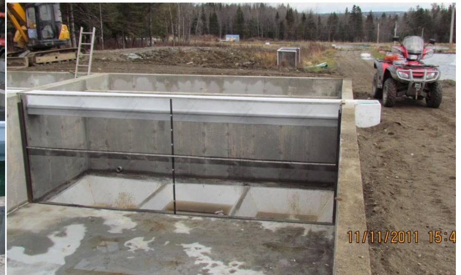
Figure A4-4: Vue des cônes de sédimentation avant le remplissage
