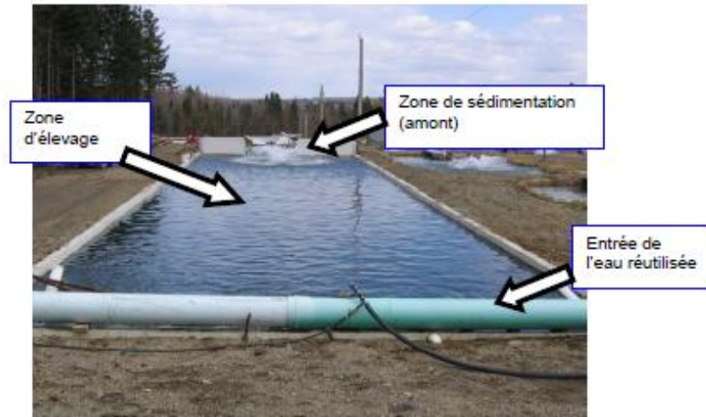
Figure A1-1: Vue d'ensemble du bassin Gilbert de première génération en opération. Vue à partir de la section amont. - Adapté de (Marcotte, 2010)
