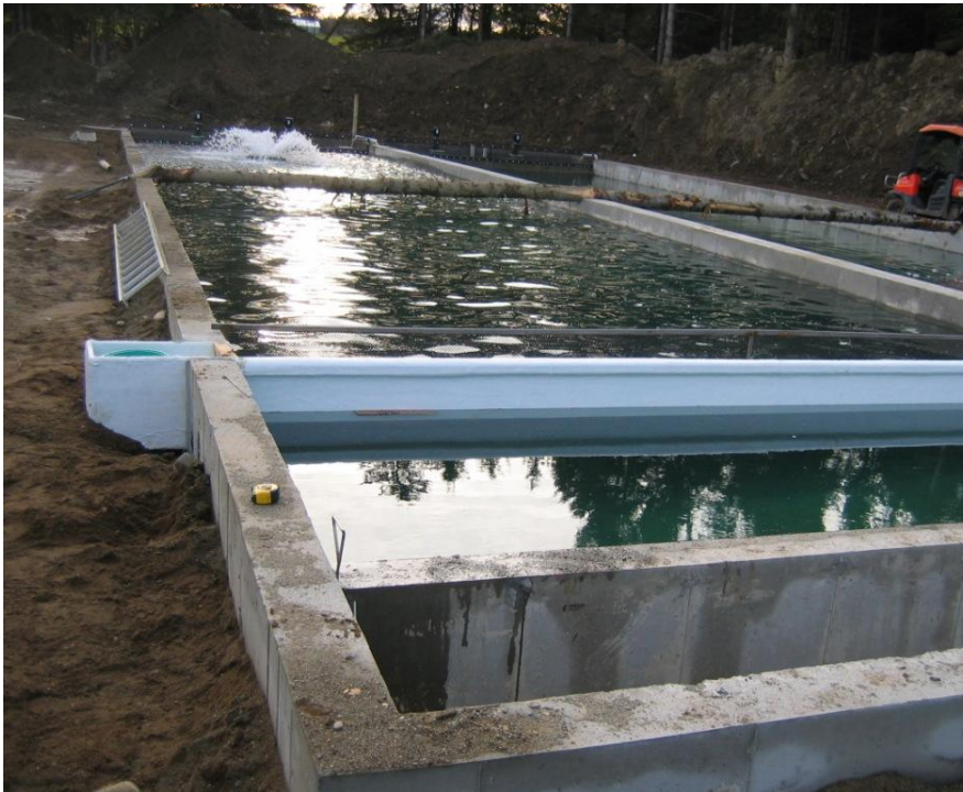
Figure A4-3: Vue d'ensemble du bassin d'élevage depuis l'aval
