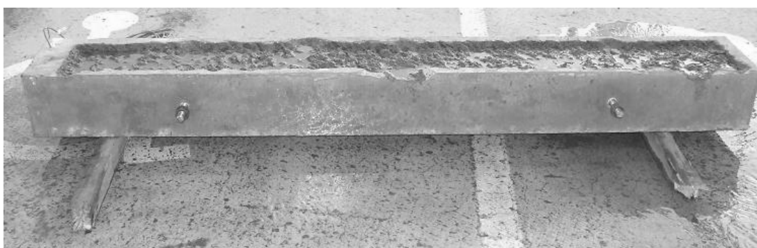
c) Poutre avec sa surface hydrodémolie
