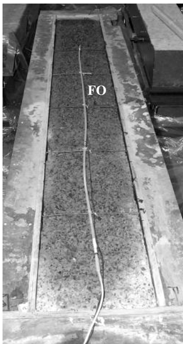
Figure 6.6 Surface hydrodémoliée d'une poutre avant la réparation
