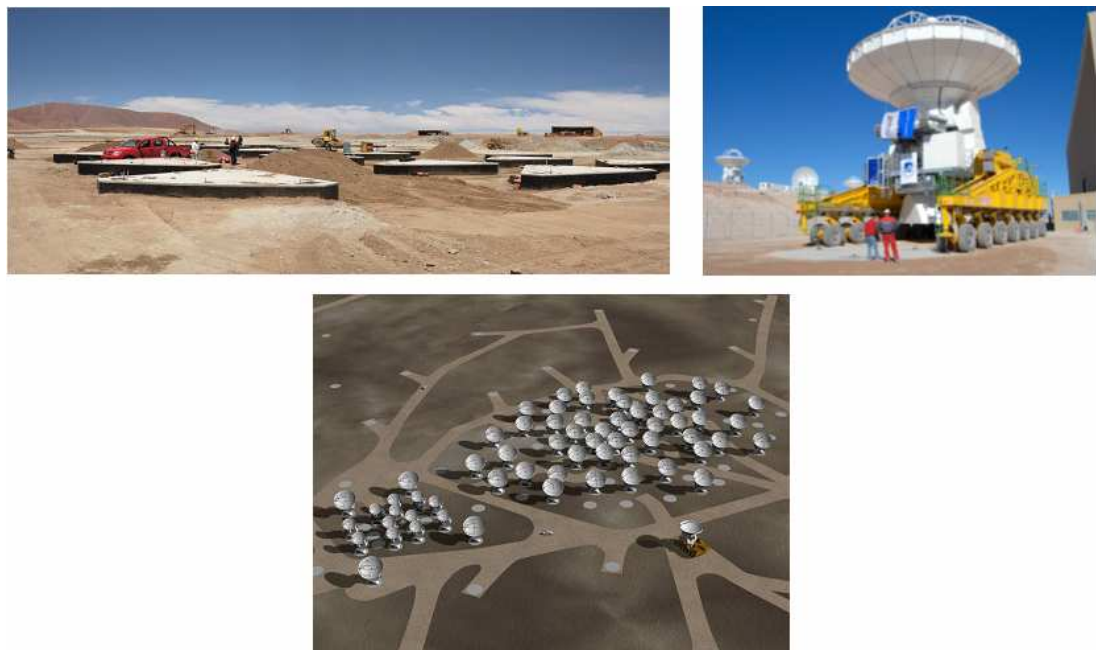
Figure 1.6: Plots en construction [1.8] et transporteur [1.9].
