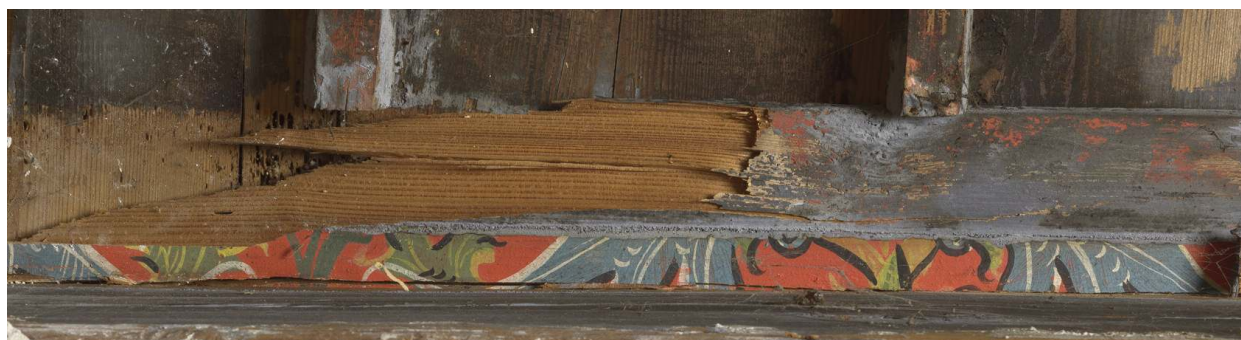
Fig. 8. Puisserguier (Hérault), maison du viguier ; lors du dégagement du faux-plafond, une partie d'un couvre-joint arrondi recouvrant une planche de rive a été arrachée. La partie sous-jacente au couvre-joint présente un décor intact où le liant n'est pas dégradé alors que la partie supérieure montre une polychromie avec un état de dégradation avancé. O. Guillon © CICRP.
