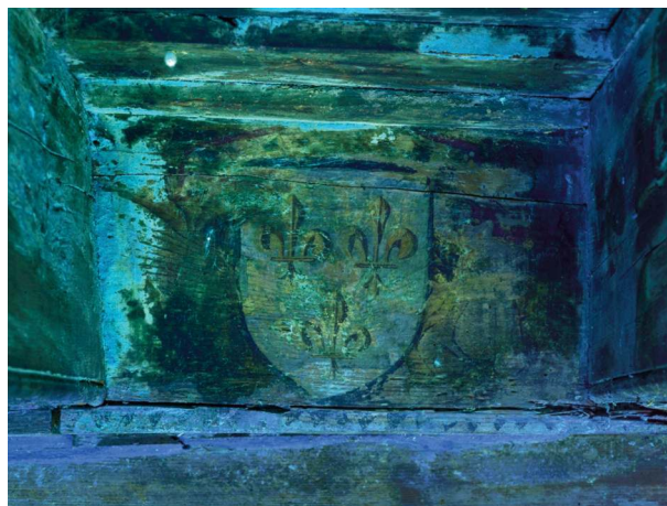
Fig. 12. Puisserguier (Hérault), maison du viguier ; image de fluorescence sous rayonnement ultraviolet du closoir du roi de France. O. Guillon © CICRP.
