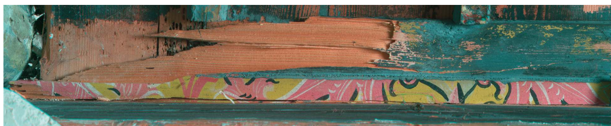
Fig. 16. Puisserguier (Hérault), maison du viguier ; image composite fausse couleur de la planche de rive. O. Guillon © CICRP.
