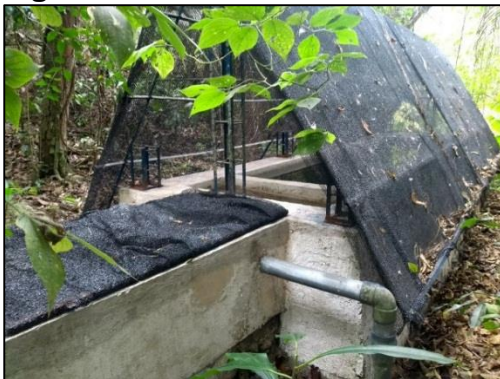
Figura 21. Paso de la Cámara de Quietamiento y el Cuerpo del Desarenador
