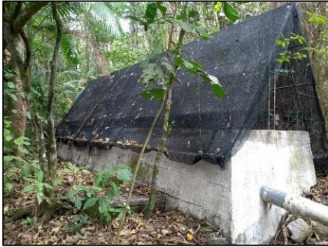
Figura 26. Salida del Desarenador
