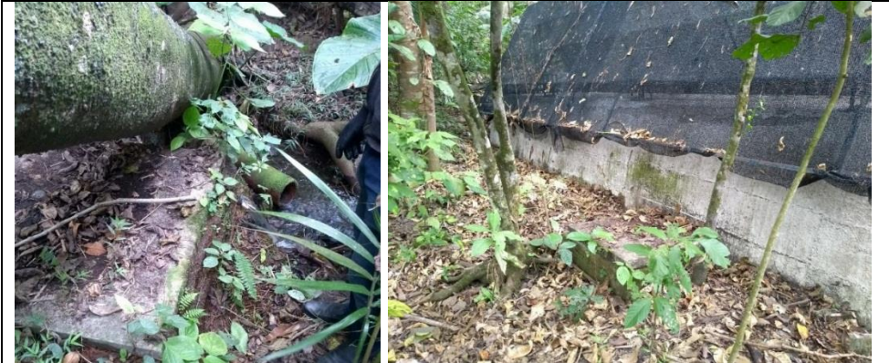
Figura 20. Tubería de Rebose
