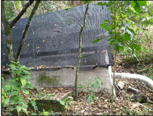
Figura 28. Línea de Conducción del Desarenador - Tanque de Almacenamiento
