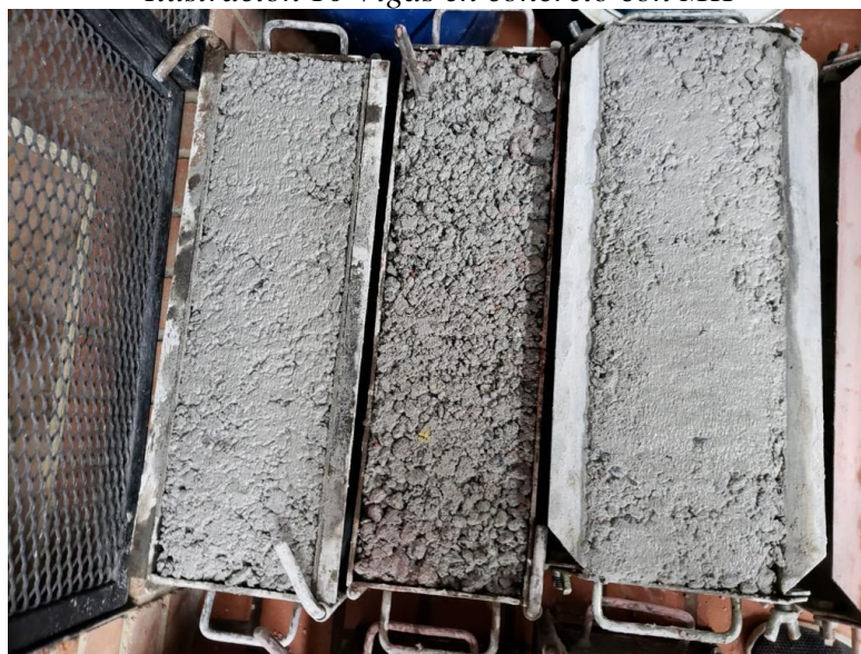
Ilustración 10 Vigas en concreto con MK
