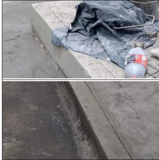
Figura 69. Creación de medias cañas. Autores
