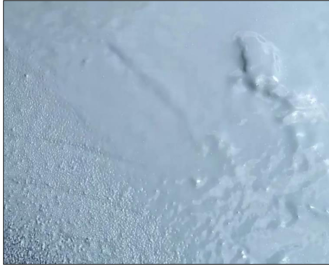
Figura 82. Espesor de la poliurea. Autores.
