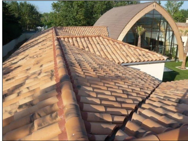
Figura 17. Cubiertas teja cerámica. HISPALYT, Tejas. Asociación Española de Fabricantes de Ladrillos y tejas de Arcilla Cocida. [En línea] [Citado el: 6 de Octubre de 2018.]
