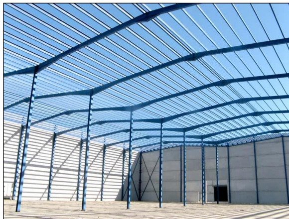
Figura 21. Cubierta plástica. PATEC. NAVES INDUSTRIALES prefabricadas. Estructuras metalicas. [En línea] 2017. https://www.patec.org/naves-industriales-prefabricadas.php
