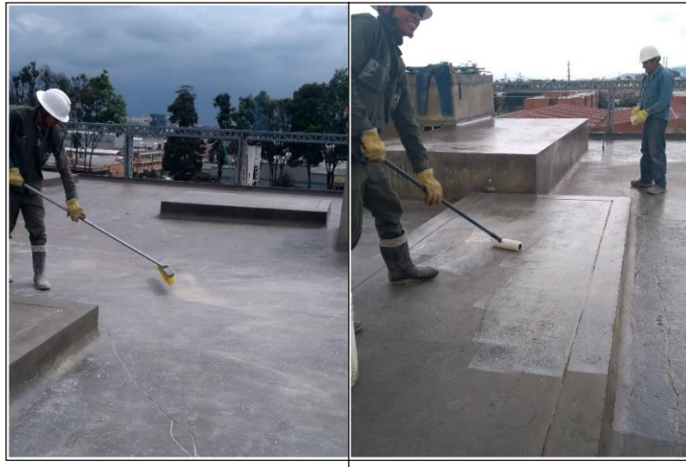
Figura 74. Aplicación de la nueva capa del imprimante. Autores
