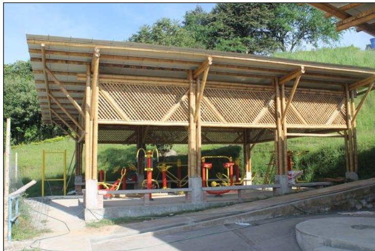
Figura 16. Cubierta de caña. BAMBOO, Guadua Constructores S.A.S. [En línea] [Citado el: 6 de Octubre de 2018.]
