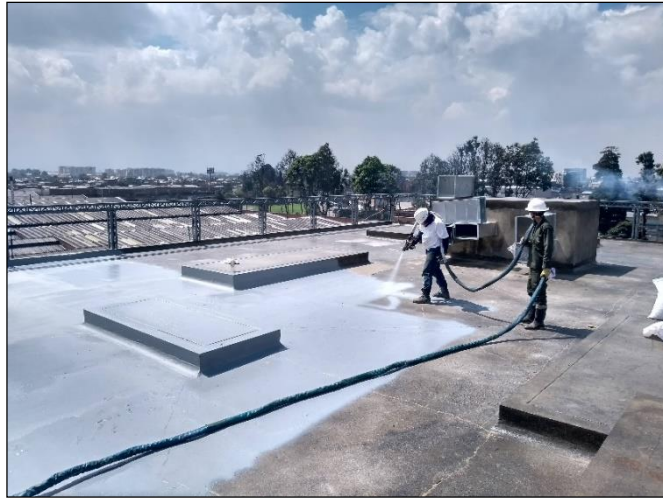
Figura 78. Aplicación de la poliurea. Autores
