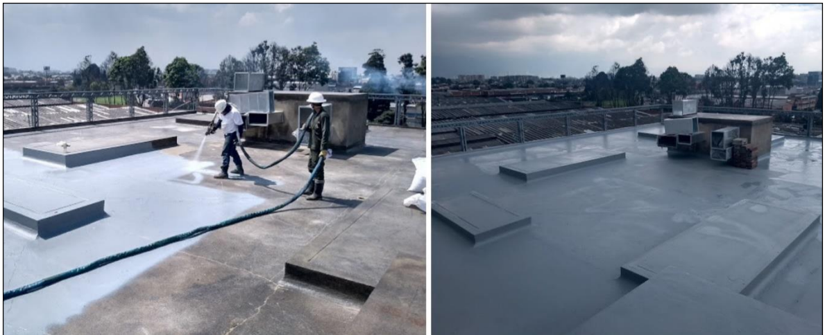
Figura 81. Durante la aplicación de la poliurea. Autores
