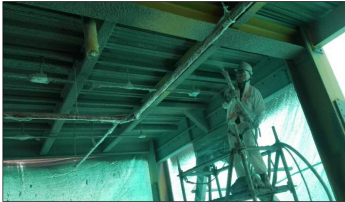
Figura 53. Aplicación mortero ignífugo. Registro fotográfico, Grupo LHS (2018)
