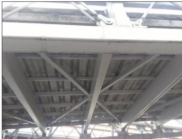
Figura 43. Steel deck en puente peatonal. Autores
