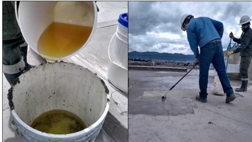
Figura 71. Aplicación del imprimante. Autores
