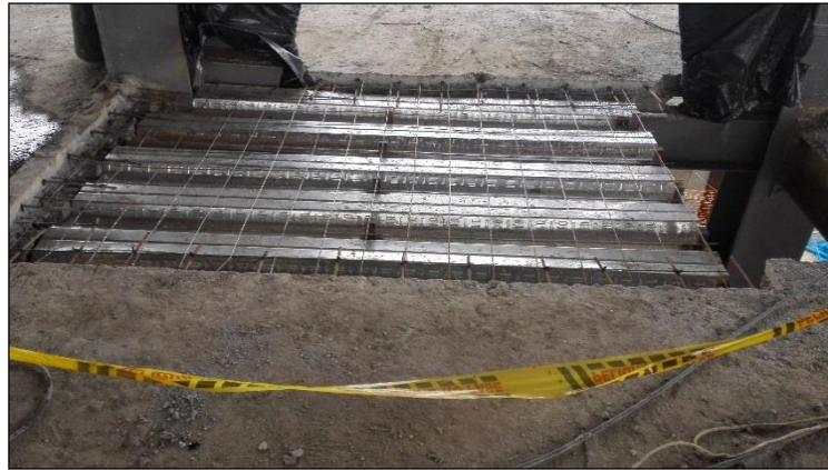
Figura 48. Pernos de cortante. Registro fotográfico, Grupo LHS (2018)
