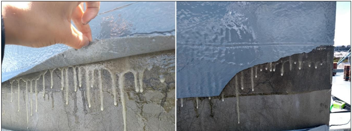
Figura 84. Poliurea en ductos. Autores
