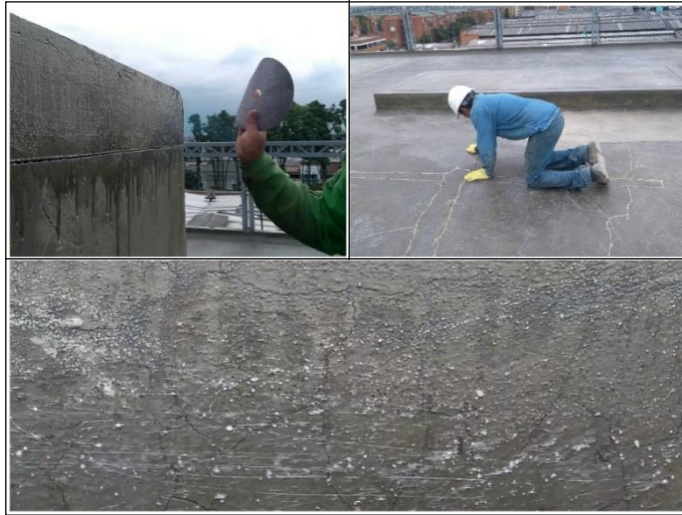
Figura 73. Reactivación del imprimante. Autores
