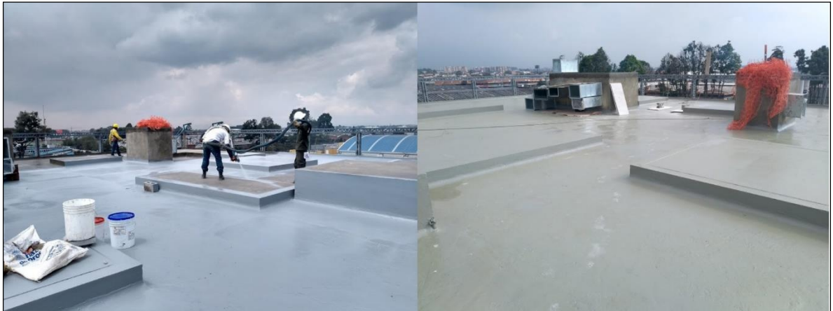
Figura 85. Cambio de color en la cubierta. Autores
