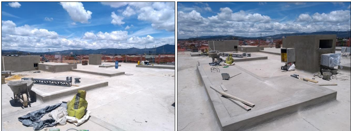
Figura 54. Cubierta de Laboratorio Central. Autores
