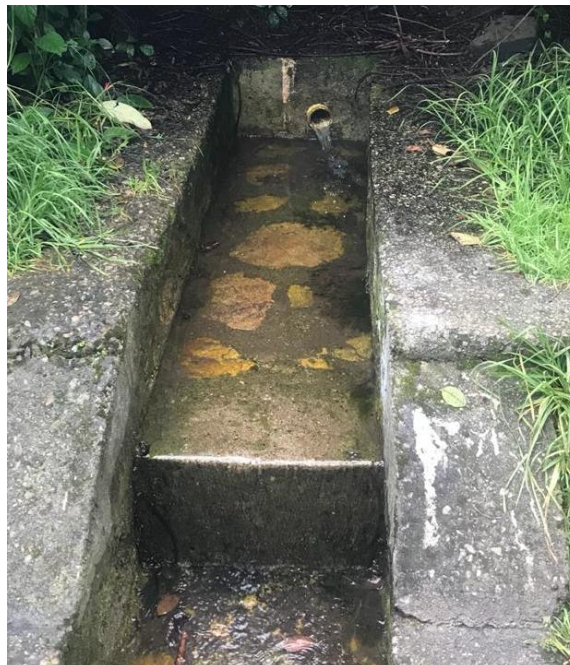
Figura 13 Vertimiento proveniente de la Quebrada Santa Bárbara
