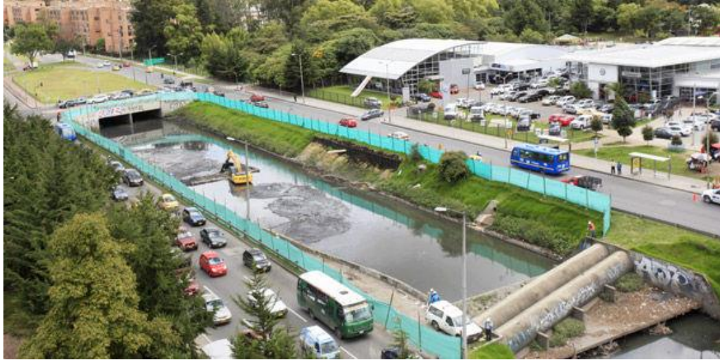
Figura 17 Mejora de filtración Canal Molinos
