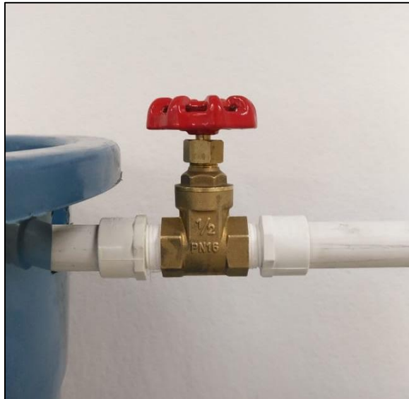
Figura 40. Incorporación de Válvula de Compuerta
