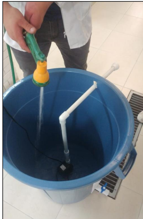
Figura 57. Tanque de almacenamiento con Bomba sumergible dentro
