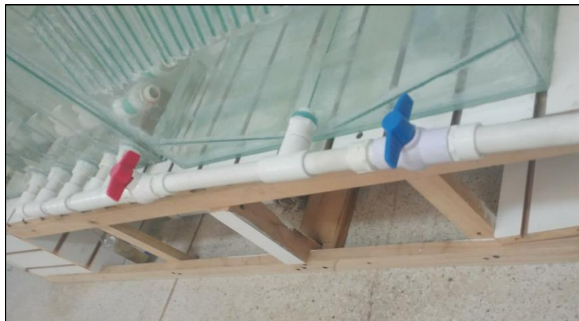
Figura 46. Rehabilitación del Sedimentador
