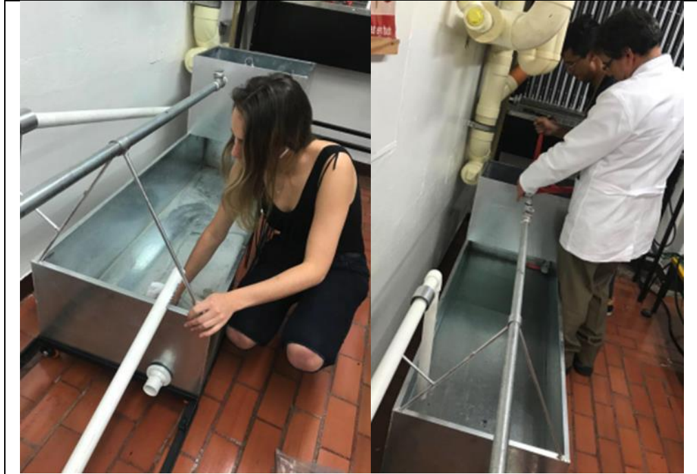
Figura 17 Ensamble de tubería en PVC y Hierro galvanizado.
