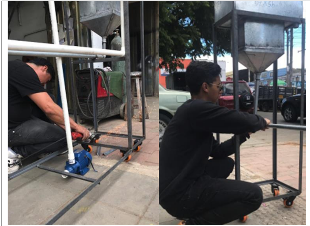
Figura 16 Ensamble de estructura metálica y tubería en hierro galvanizado.
