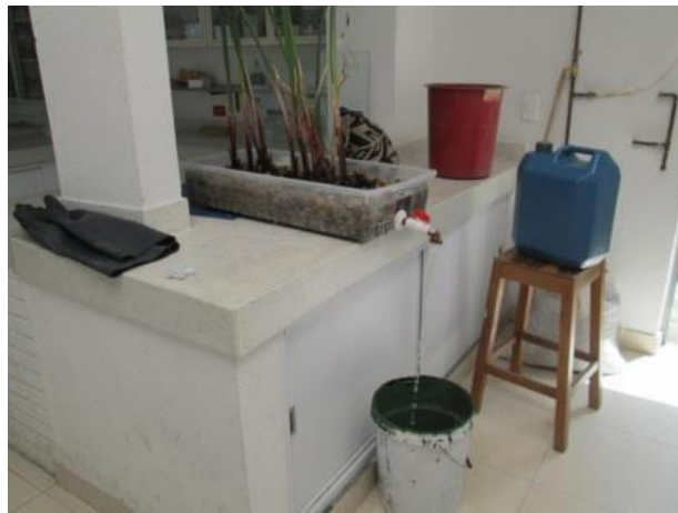
Figura 14. Proceso de recirculación de agua tratada en humedal artificial
