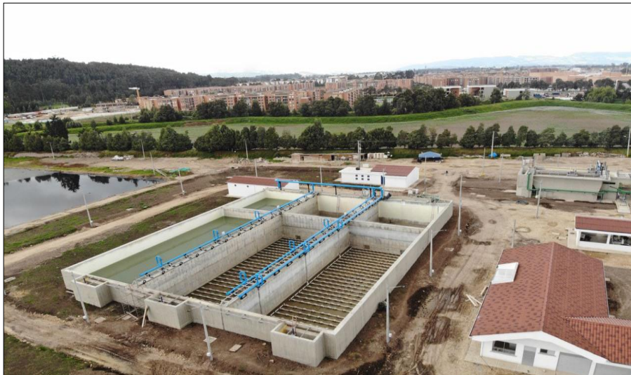
Ilustración 22. Reactores Biológicos
