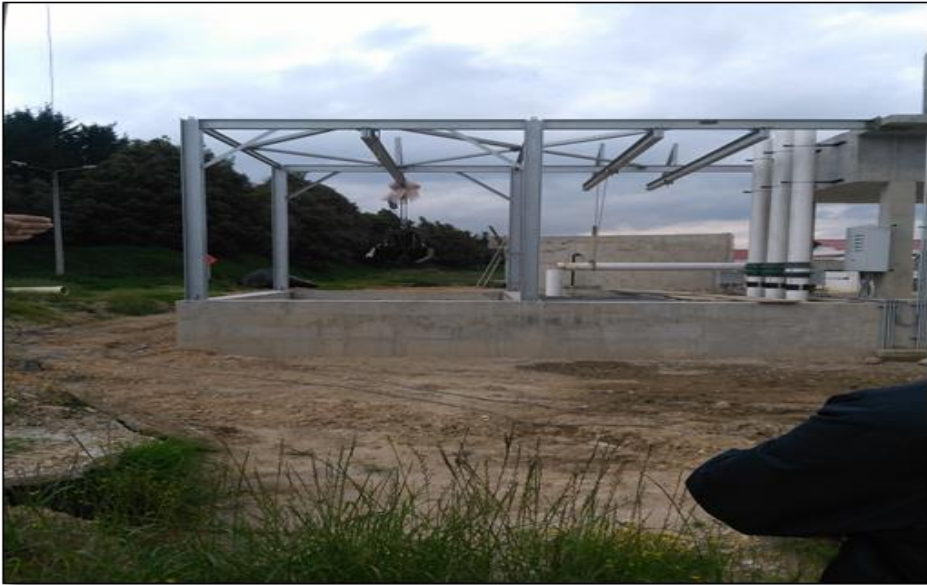
Ilustración 12. Pozo de gruesos
