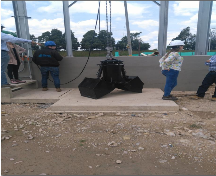
Ilustración 14. Pozo de gruesos y cuchara bivalva
