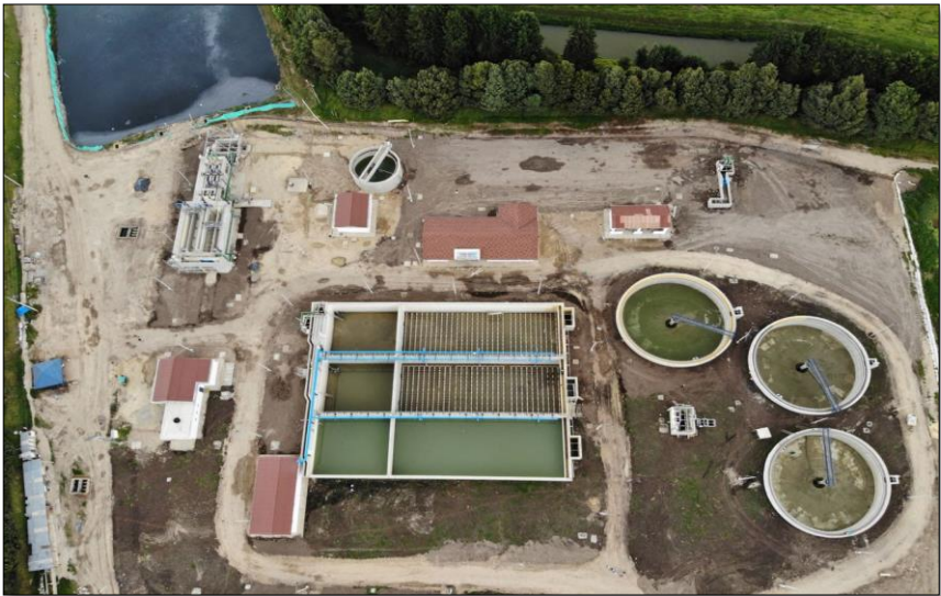
Ilustración 24. Planta de Tratamiento de Aguas Residuales. Madrid-Cundinamarca
