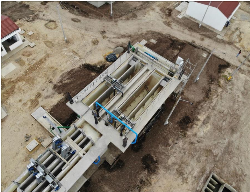
Ilustración 16. Canales de desbaste
