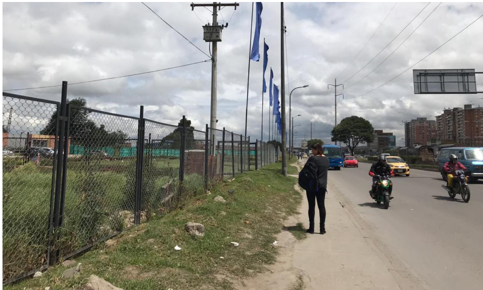
Figura 2. Estado de andenes en vías principales. Fuente: Elaboración propia.
