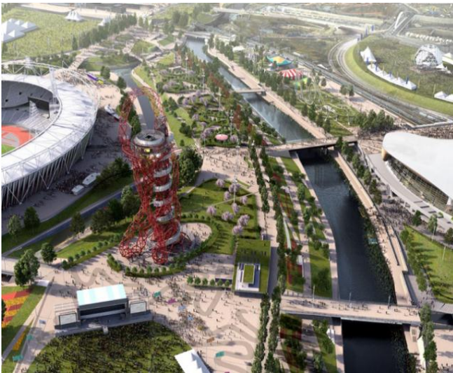
Figura 7 - Vista aérea desde la parte ubicada más al sur - Fuente (Fernández, 2013 , p 82)
