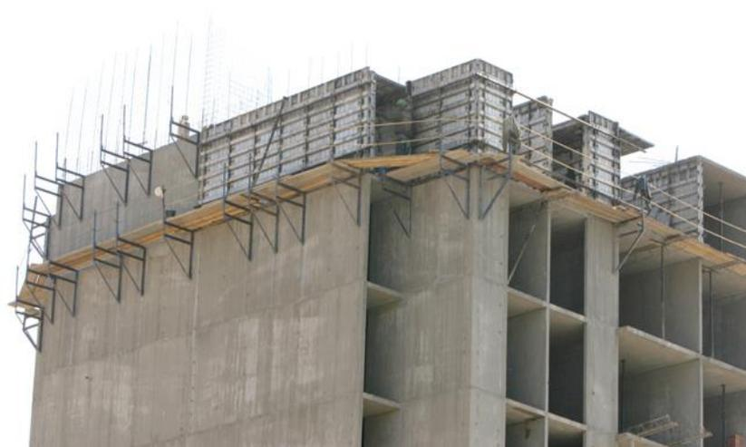
Figura 4 Formaletas Sistema Industrializado Fuente: <http://blog.360gradosenconcreto.com>
