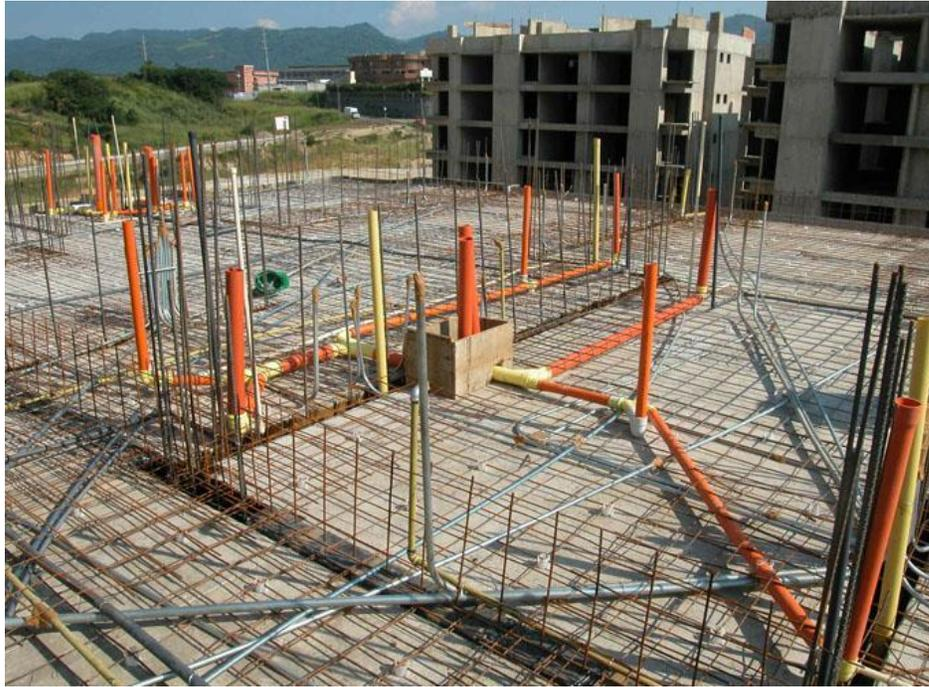
Figura 9 Instalaciones eléctricas e hidráulicas Fuente: Revista Flickr – Concrete Forms
