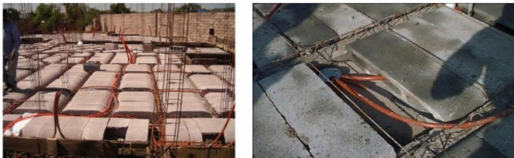
Figura 16 Instalaciones eléctricas e hidráulicas
