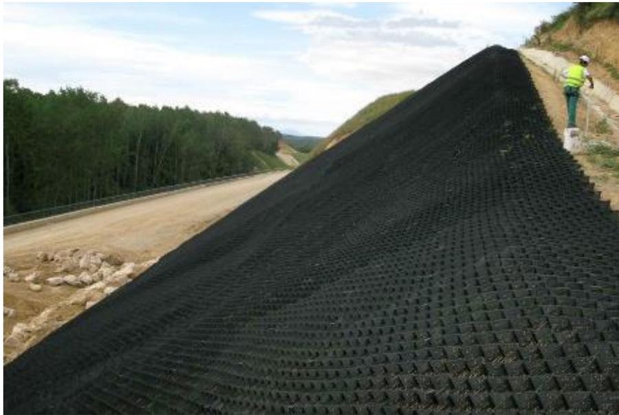
Ilustración 7 Geoceldas Estabilización de Talues. (Fuente: <https://www.controlerosion.es/productos/geoceldas>)
